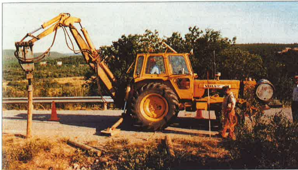
Ill. 19. Traktorgraver med slaghammer, stolpesetting for vegrekkverk. Tanadalen, Finn- mark, 1980. Foto: B. Prebensen.
