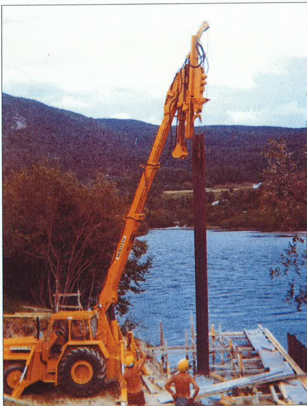
Ill. 25. Moelven mobilkran, her som redskapsbærer. Kjøretøy er Volvo BM traktor. I arbeid med spunting. Beiarn, Nordland, 1974. Foto: Arkiv Nordland vegkontor.
