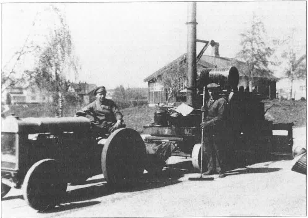
Ill. 3. Traktor i asfalt vegarbeid, 1930-tallet. Foto: Arkiv Akershus vegkontor.
