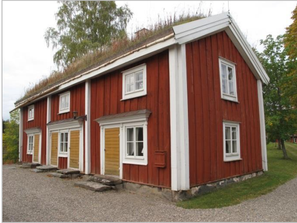
Takfoten har åtgärdats och hängrännan justerats.
