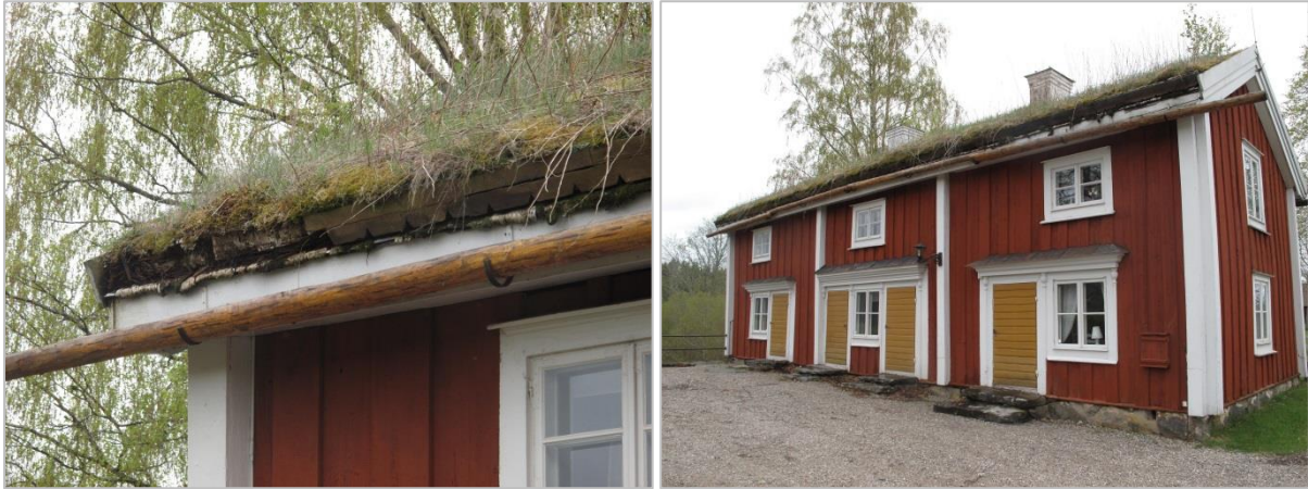
Delar av mullåsen på drängstugan har trillat ner. Mullåsen är mycket rötskadad.
