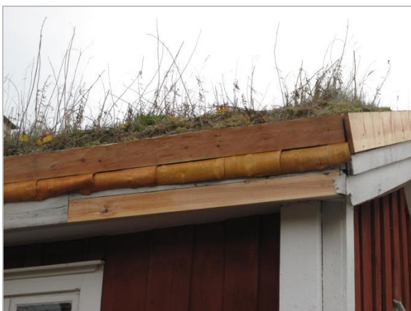
Delar av takfotsbrädan har ersatts liksom översta vindskivan.
