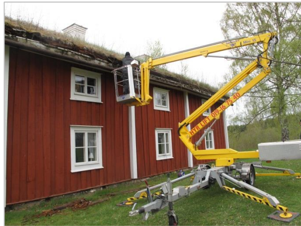
Taket undersöks inför arbetena.
