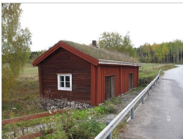
Smedjans takfot har åtgärdats.
