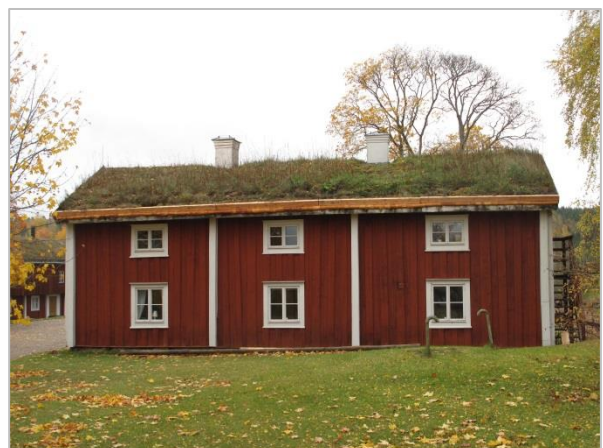
Takfoten har åtgärdats.
