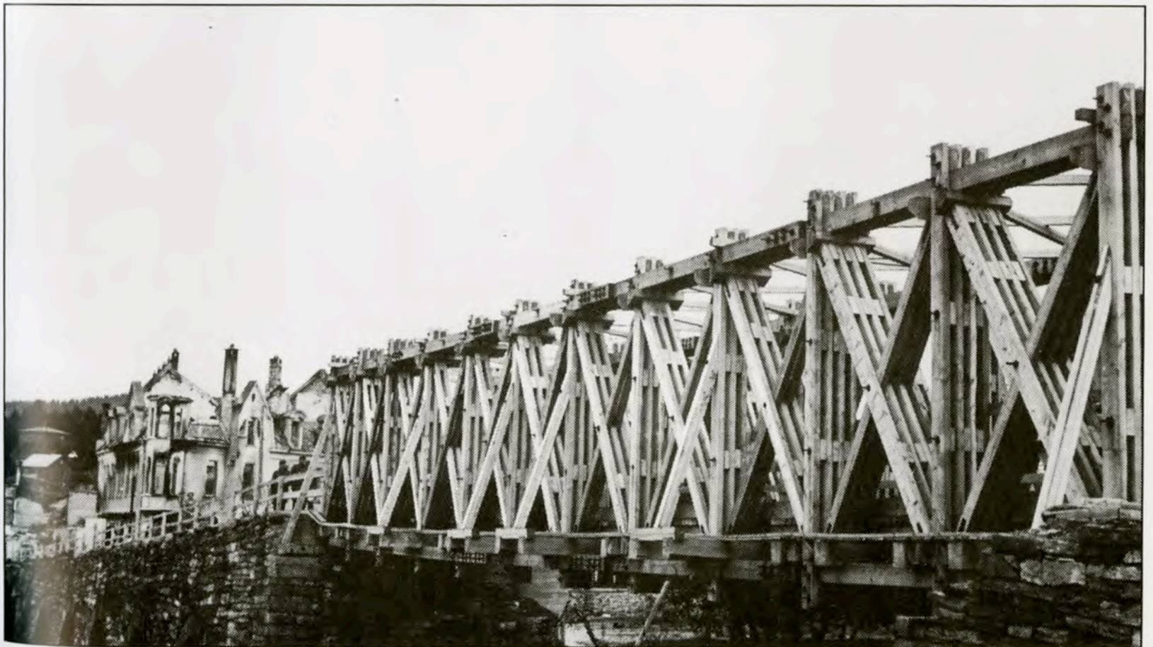
Steinkjer bru. Denne tyske pionerbrua ble stående til desember 1941. I bakgrunnen Nordstrømgården der vegkontoret holdt til, og som gikk med i bombingene 21. april 1940. Foto: Nord-Trøndelag vegkontor.
