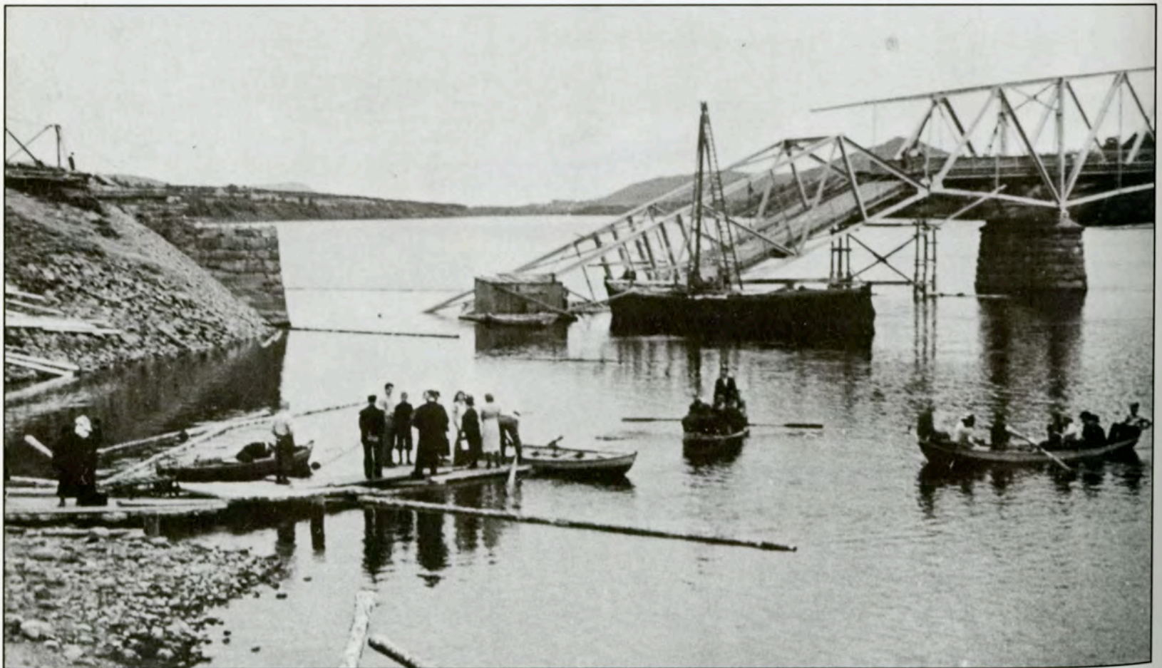
Sundbrua på Eidsvoll i Akershus ble sprengt. Foto: Eidsvoll kulturkontor.
