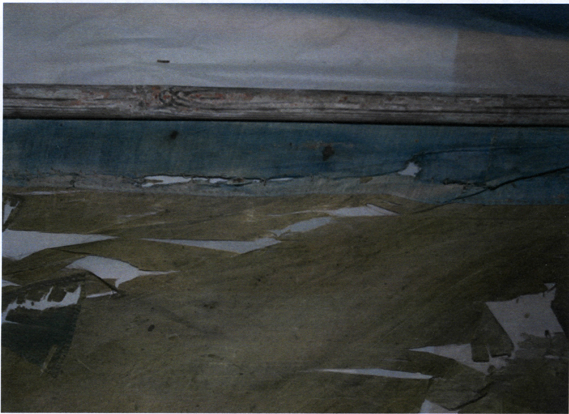
Bild 10. ST 27:273. Detalj av äldre lagning av linneremsan.
