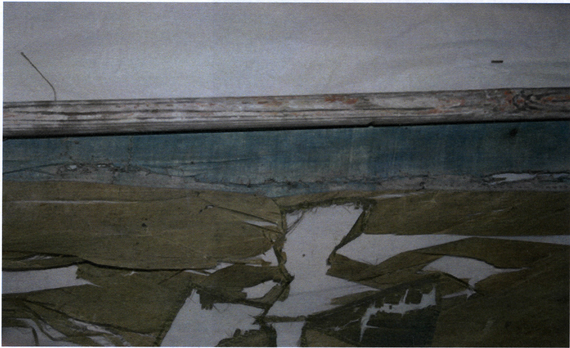
Bild 8. ST 27:273 Detalj av äldre lagning av linneremsan.
