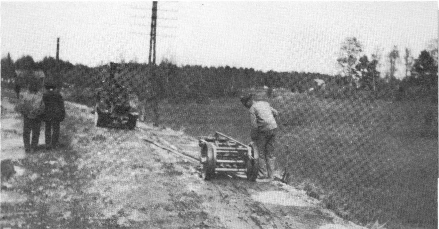
Rivare, Verkstads AB Tjust, demonstreras på Svenska vägföreningens första instruktionskurs i mönsterväghållning, Enebyberg, Stockholms län, 1914.
