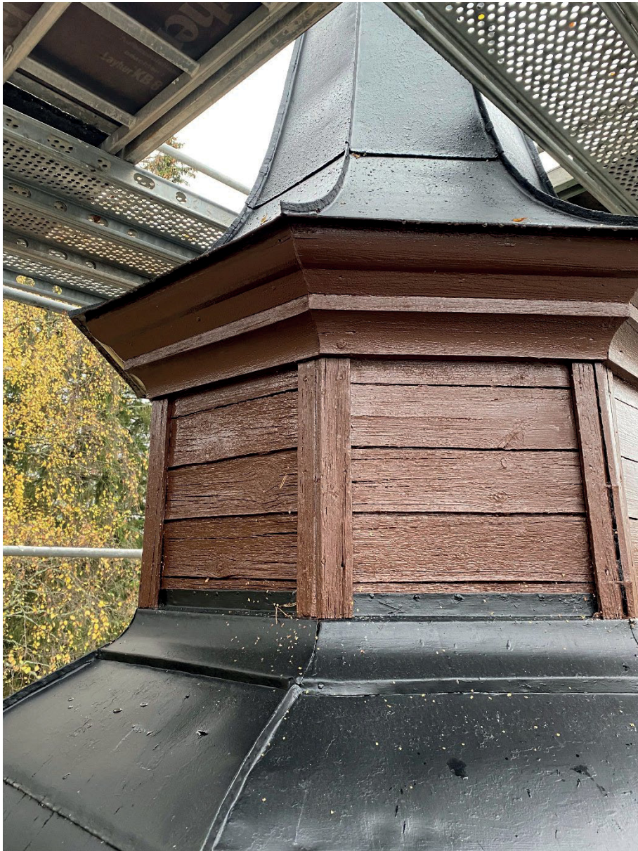
Figur 16. Nymålad panel mellan de båda plåtpartierna. Nymålad plåttäckning. Foto: 2021-10-14.
