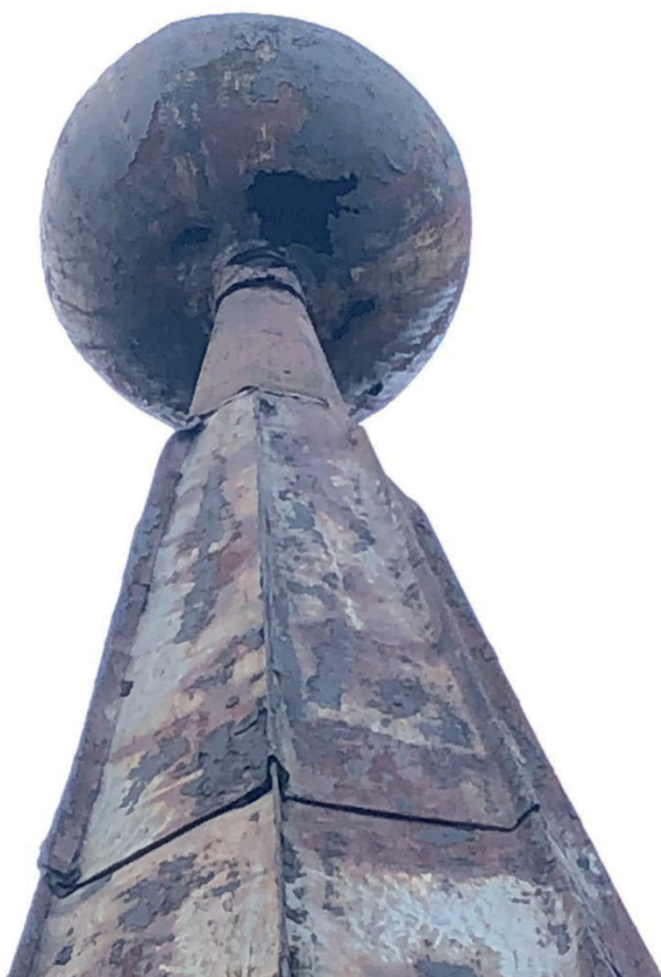
Figur 7. Spira och klot innan påbörjade arbeten, 2020-10-28.
