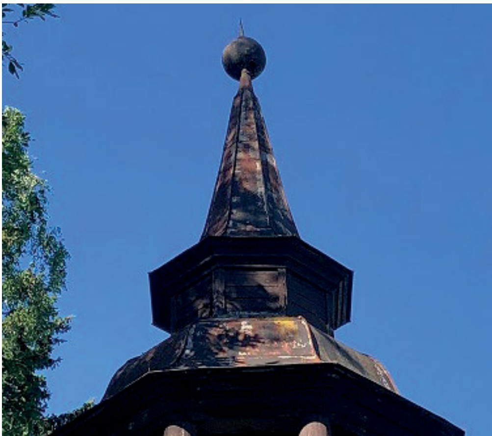
Figur 6. Plåttak, spira och klot dokumenterat från marken 2020-07-03.
