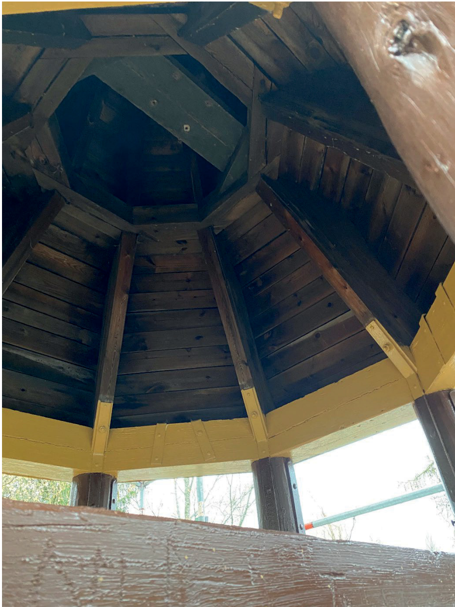
Figur 15. Den profilerade takfoten sedd från klockdäcket. Foto: 2021-10-14.
