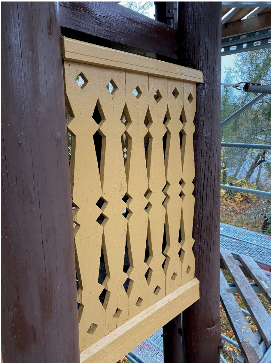
Figur 14. Nymålade pelare och räcke. Överliggaren är bytt. Foto: 2021-10-14.
