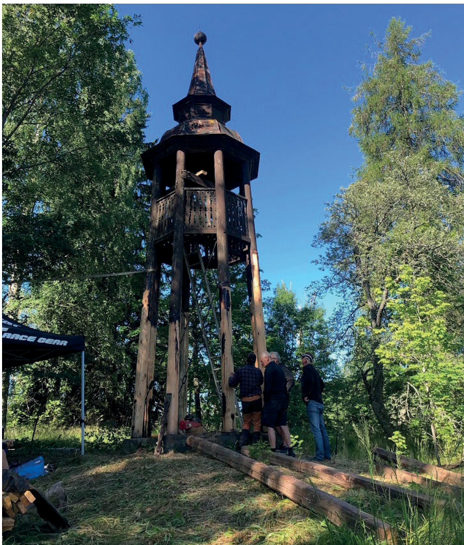
Figur 9. De gamla stolparna har lagats i med nytt virke längst ner. De gamla delarna ligger på marken. Foto: 2020-07-03.
