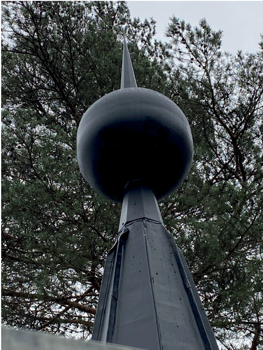
Figur 13. Den nya spiran och kulan är på plats och all plåt har rengjorts och målats. Foto: 2021-10-14.
