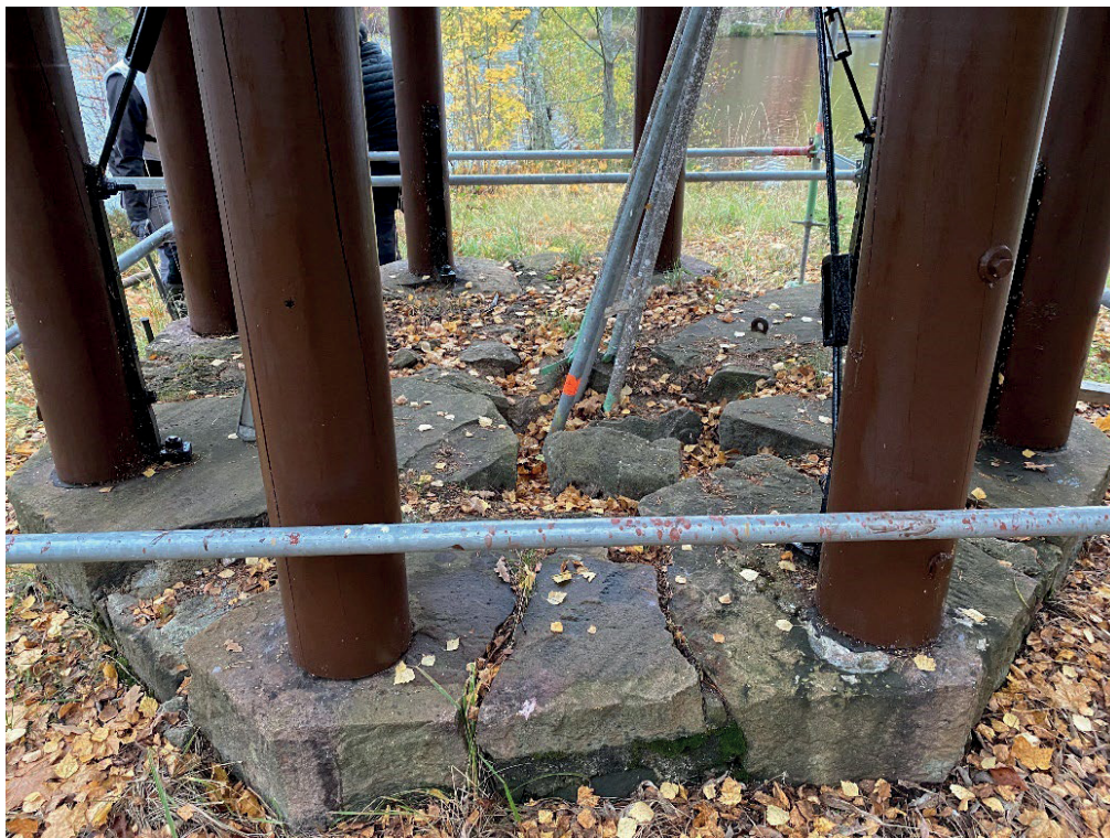
Figur 18. Här är alla tidigare urfallna stenar återlagda i konstruktionen. Stenmjöl saknas ännu. Foto: 2021-10-14.
