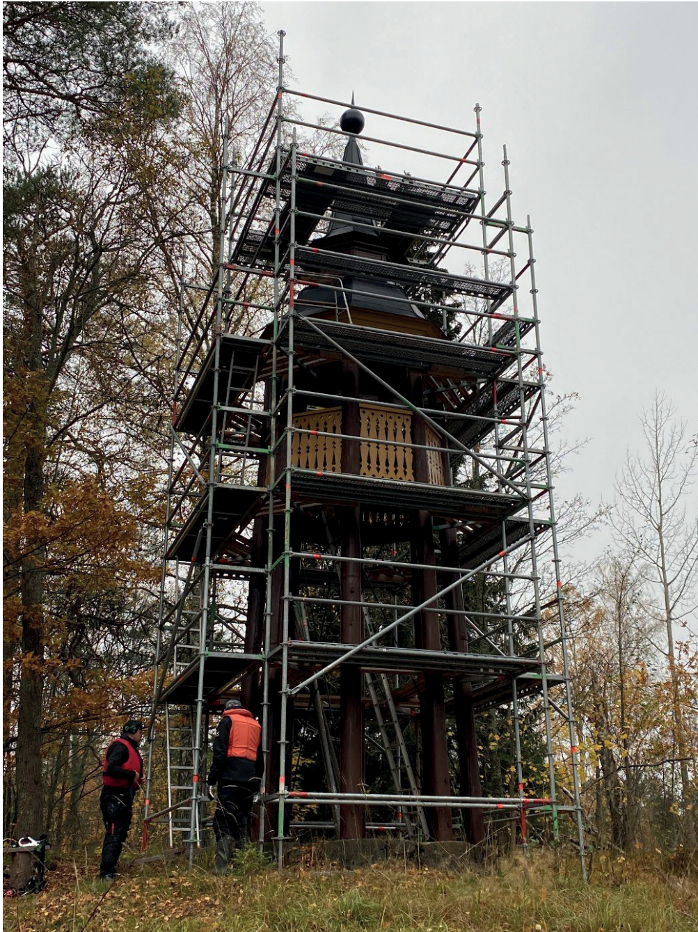
Figur 19. Klocktornet vid slutbesiktningen 2021-10-14.
