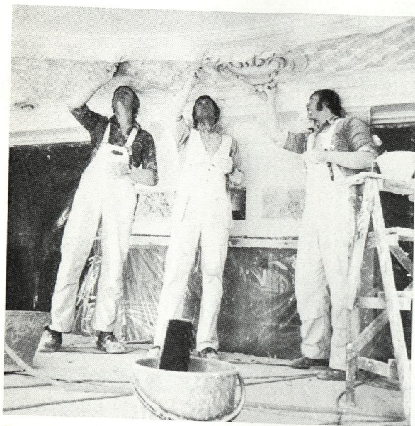
Det var ett omfattande arbete att sätta upp och finputs det rikt dekorerade taket i minnesrummet.
