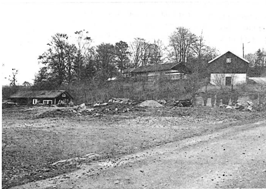
Ladugårdsplanen 1995. Längst till vänster är den bevarade delen av hönshuset (Nr 10), i mitten bostadshuset från 1968 och till höger källarvinden (Nr 11). Neg nr C 2762:35.
