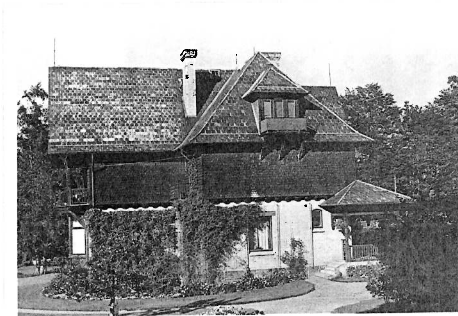
Mot söder. Foto 1970. Neg nr B 540:84:30
