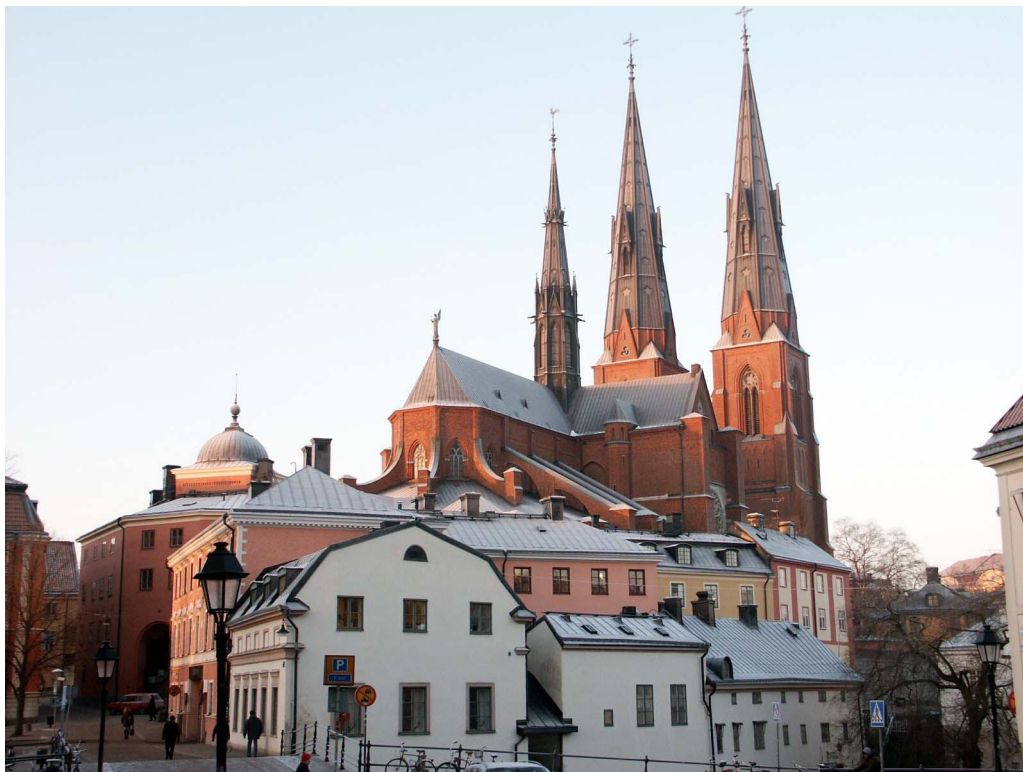
Vy från Gamla torget 2005. Här ses de svankryggiga strävbågarna som är resultatet av 1940-talets skyddsarbeten. Norra delen av koret har kvar de nygotiska strävbågarna från 1890-talet men berövade sina fialer.
