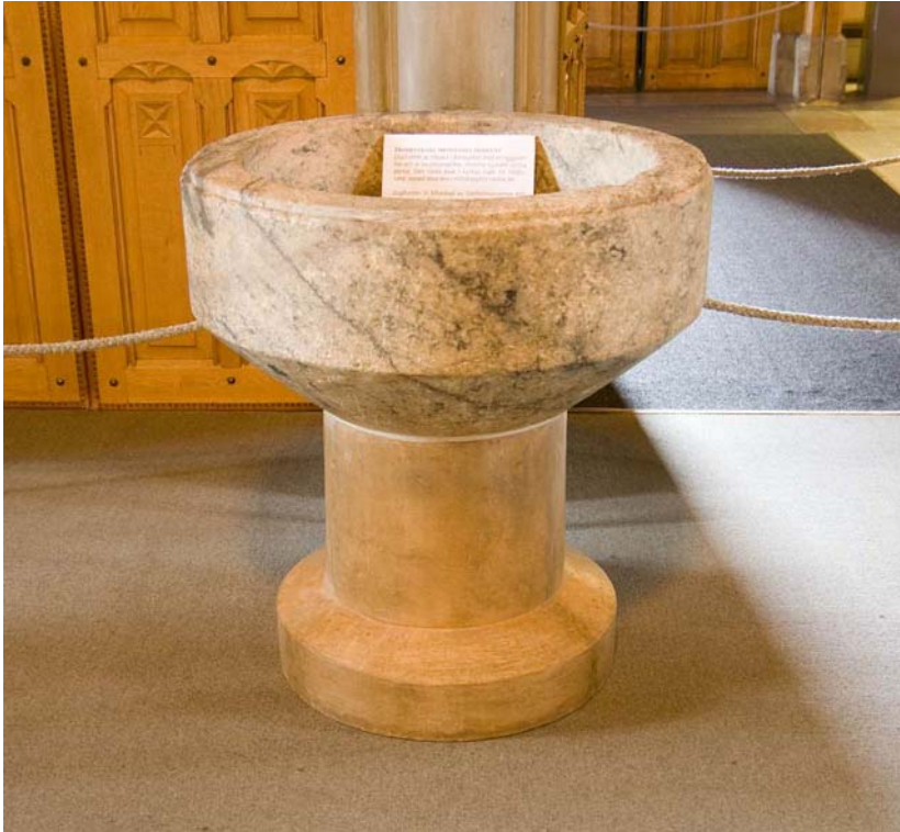
Dopfunten har försetts med nytt skaft och ny fot av infärgad betong. DIG007837
