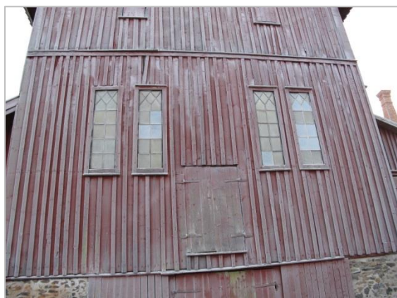
Masugnsbyggnaden efter att fönstren åtgärdats.
