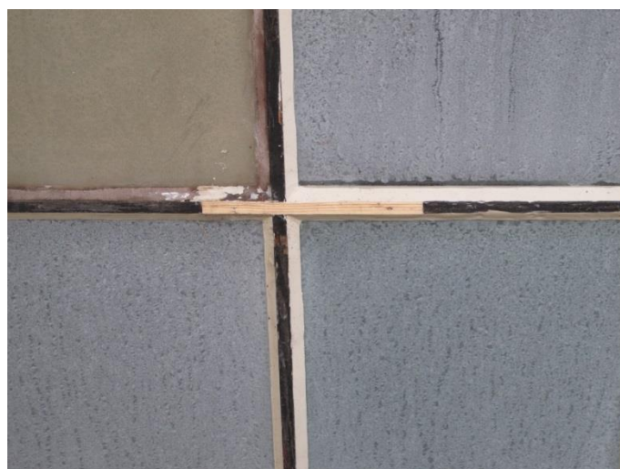
Fönster på labbit efter åtgärder. Här sattes en båge tillbaka som var urplockad. Det gula "glaset" utgörs av makrolonglas. Bilden ovanvisar lagning av en spröjs.
