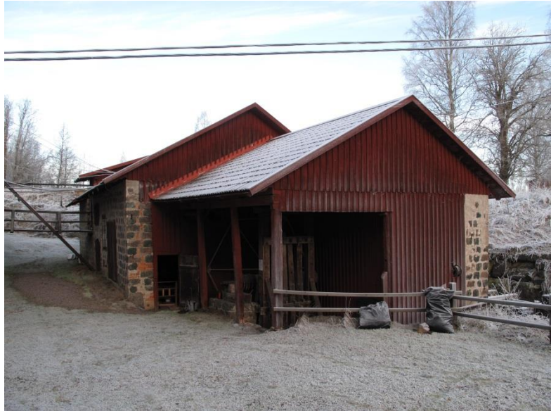
Slagstampsbyggnaden och turbinhuset efter åtgärder.
