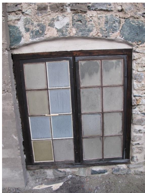
Fönster på labbit efter åtgärder. Här sattes en båge tillbaka som var urplockad. Det gula "glaset" utgörs av makrolonglas. Bilden ovanvisar lagning av en spröjs.
