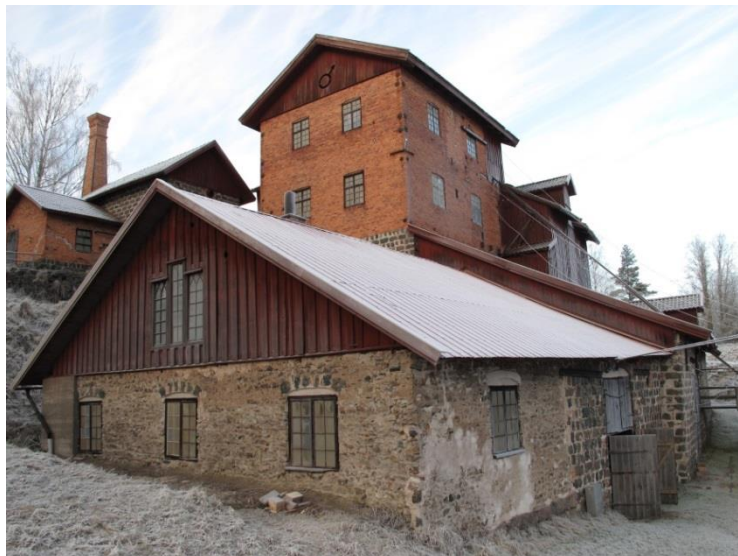
Masugnsbyggnaden och labbit efter att fönstren åtgärdats.
