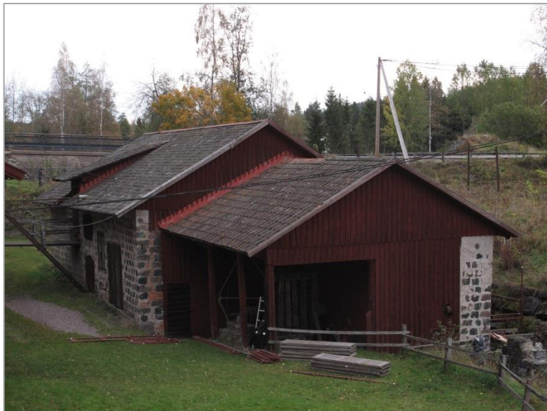
Slaggstampsbyggnaden med turbinhuset bakom. Taket på slaggstampshuset behövde läggas om.
