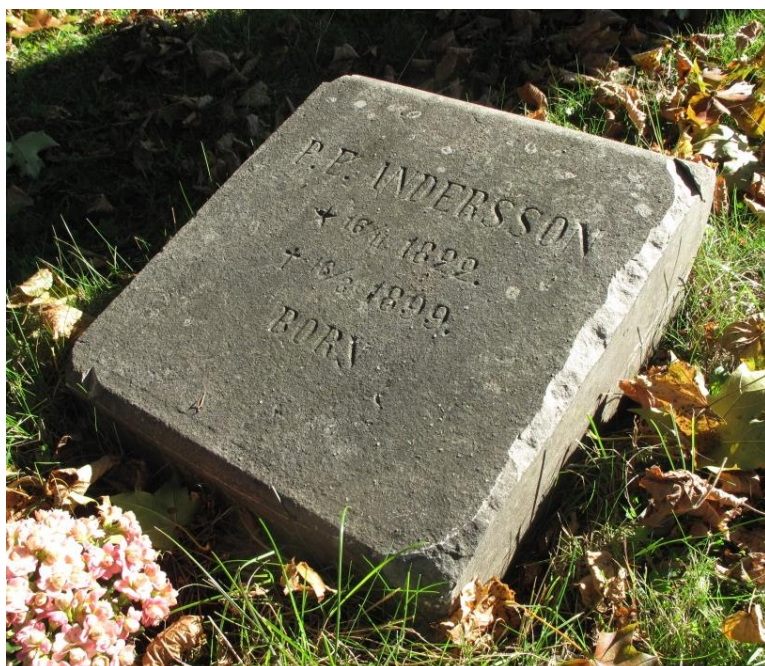
Kalksten med mekaniska samt vittringsskador, kv 2, gravnr 139. Höger bild visar kalkstensvård med avbrutet kors, kv 2, gravnr 98.
