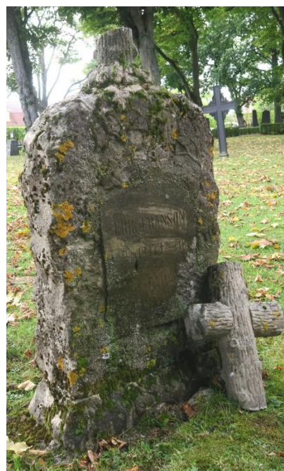
Kalksten med mekaniska samt vittringsskador, kv 2, gravnr 139. Höger bild visar kalkstensvård med avbrutet kors, kv 2, gravnr 98.
