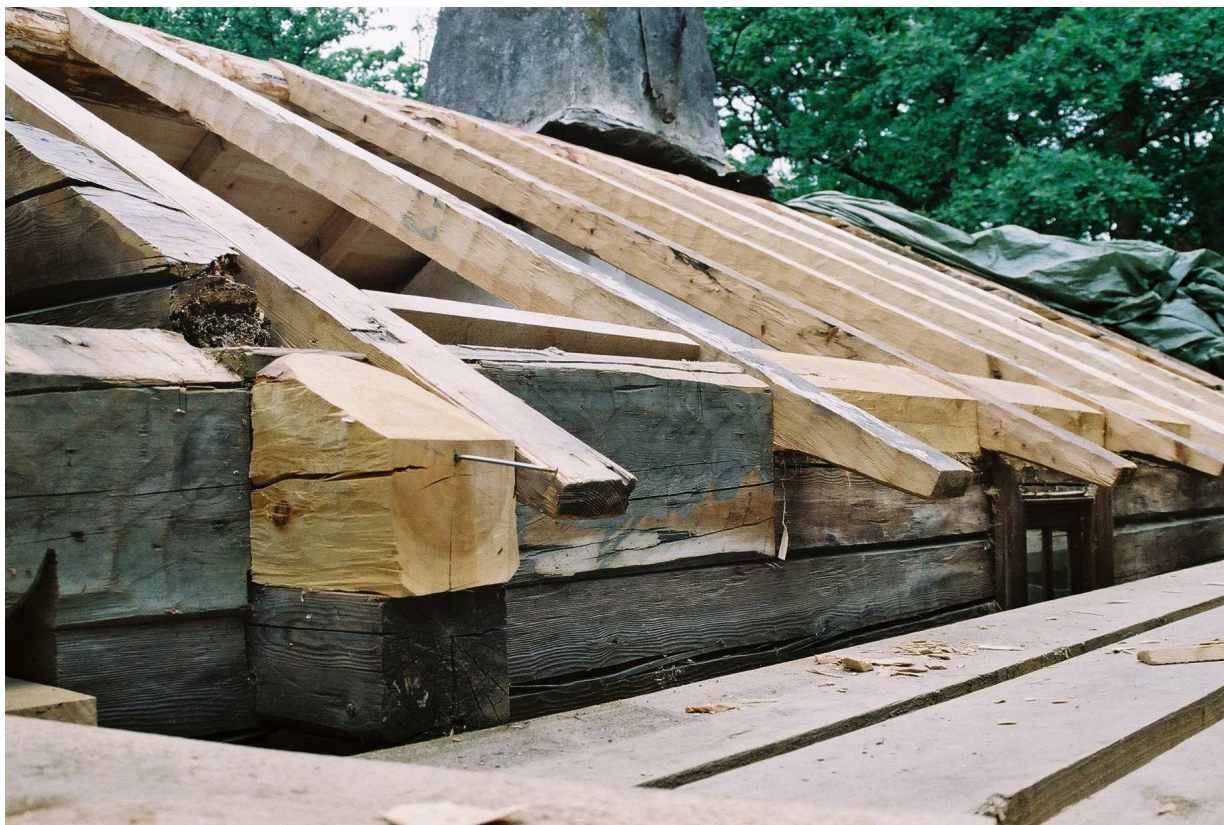
Bakre takfallet på stugan med nya sparrar.
