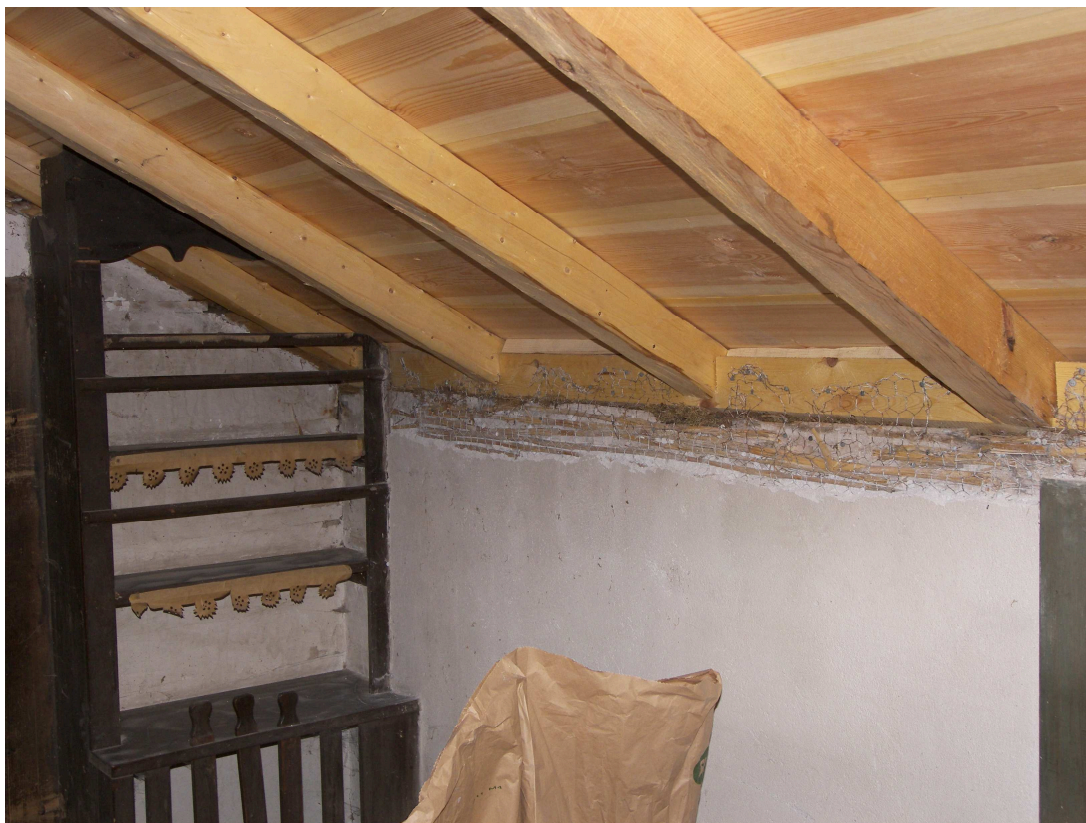
Insidan av det nya taket i stugan.
