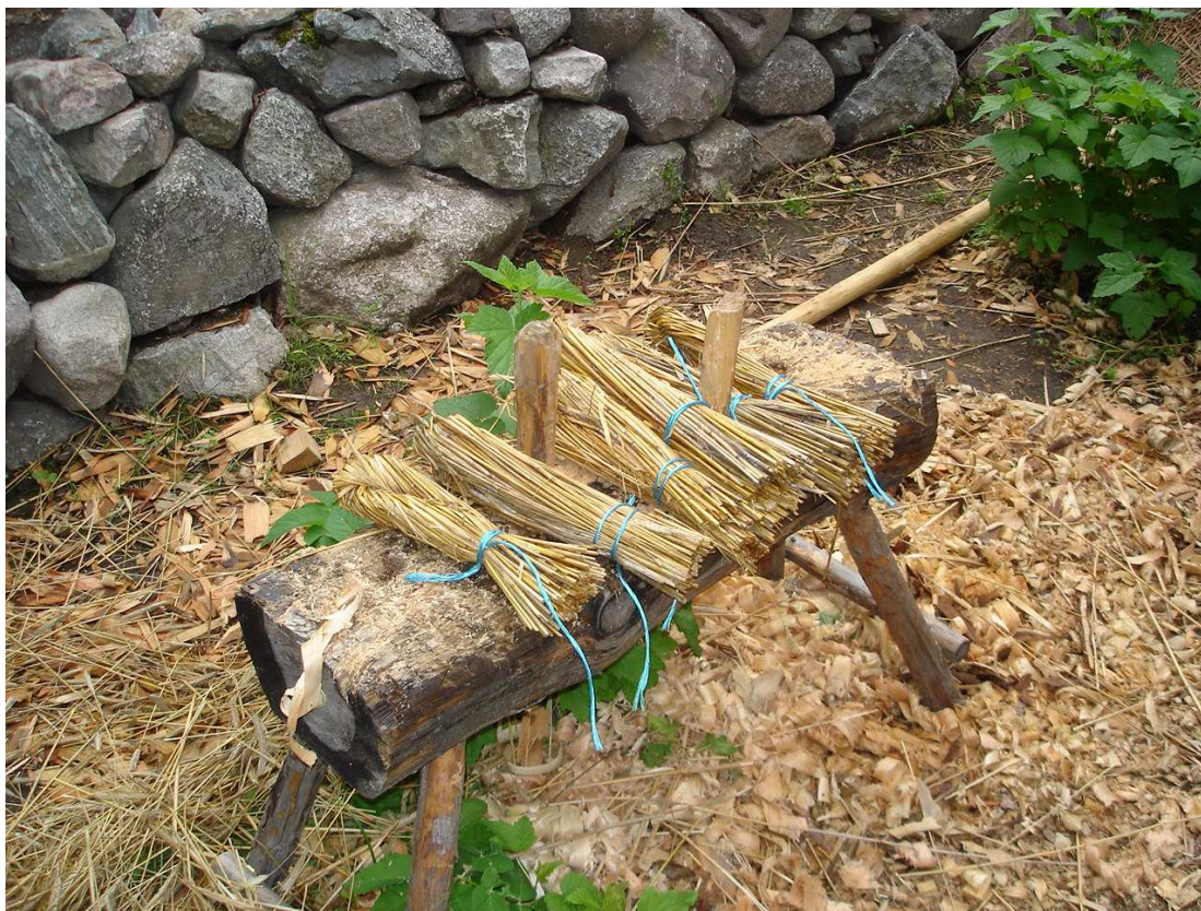
Öfsalockarna till förstärkning av takfoten.
