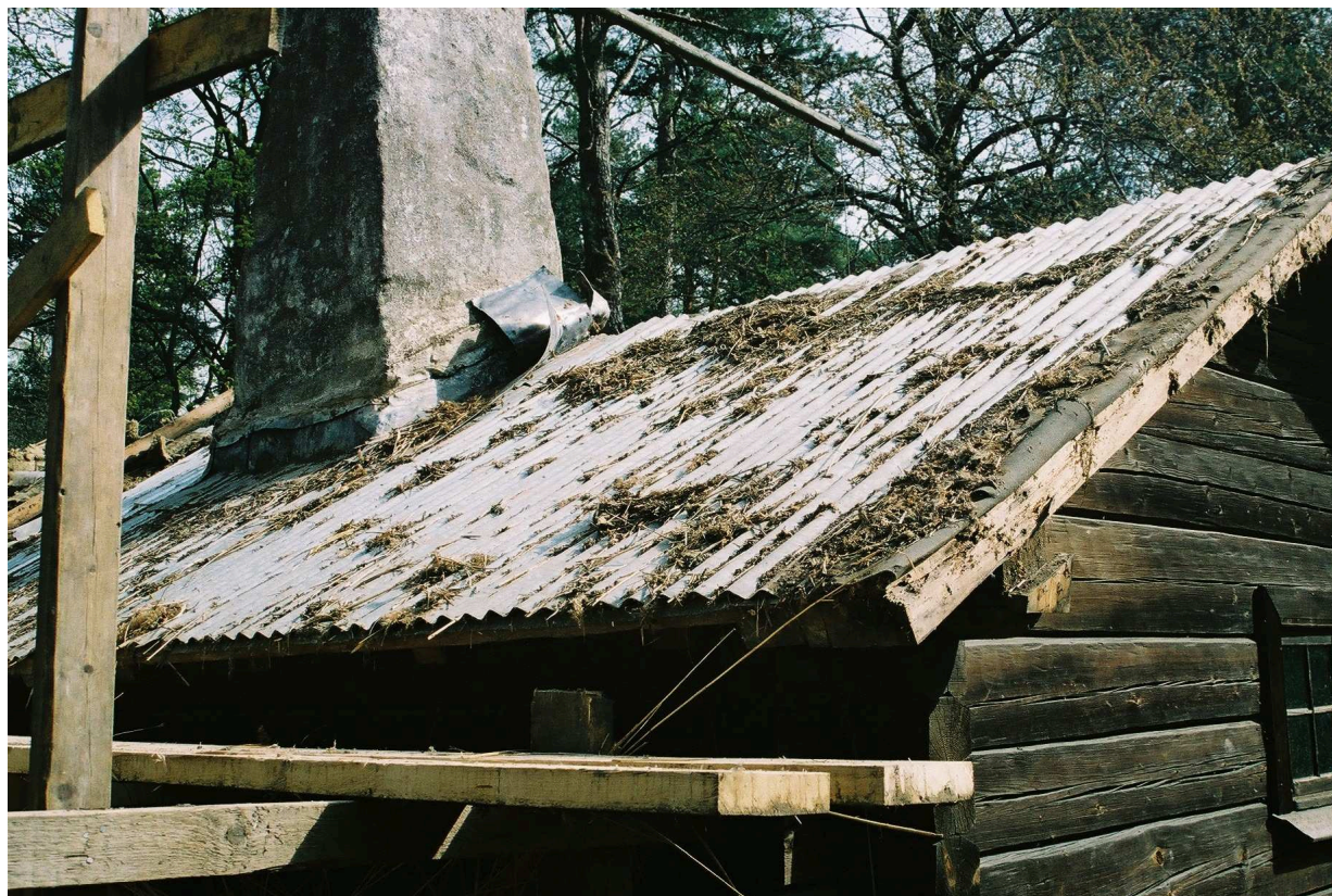
Rivning av brandskyddet med plåt närmast takpanelen.
