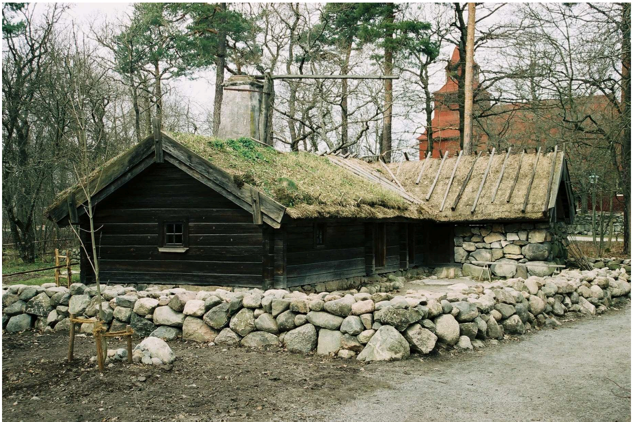
Hornborgastugan före takrenoveringen 2007.
