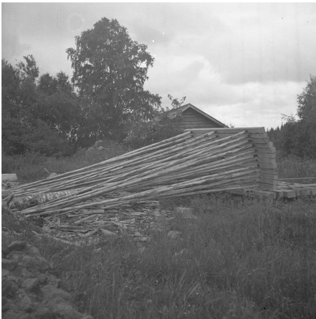
En bild från takomläggningen som genomfördes 1939. De långa sparrarna har fästs i vågbord, en konstruktion som användes i undertaket. Foto: Örebro läns museum OLM-1939-297
