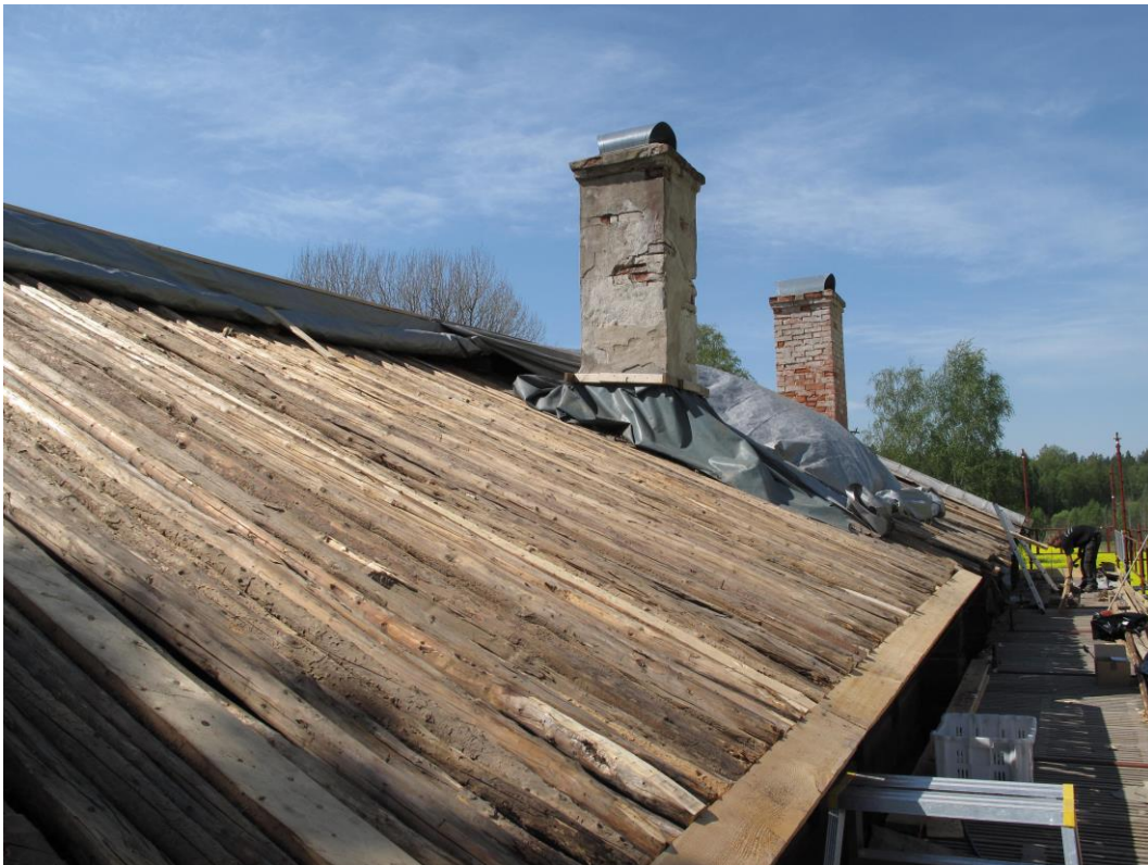
Norra takfallet efter att ett nytt vågbord monterats och trolen lagts om.
