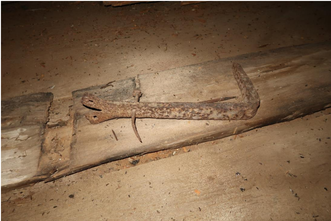
Järnkrok för mullås samt vågbord. Delarna är troligtvis ursprungliga.
