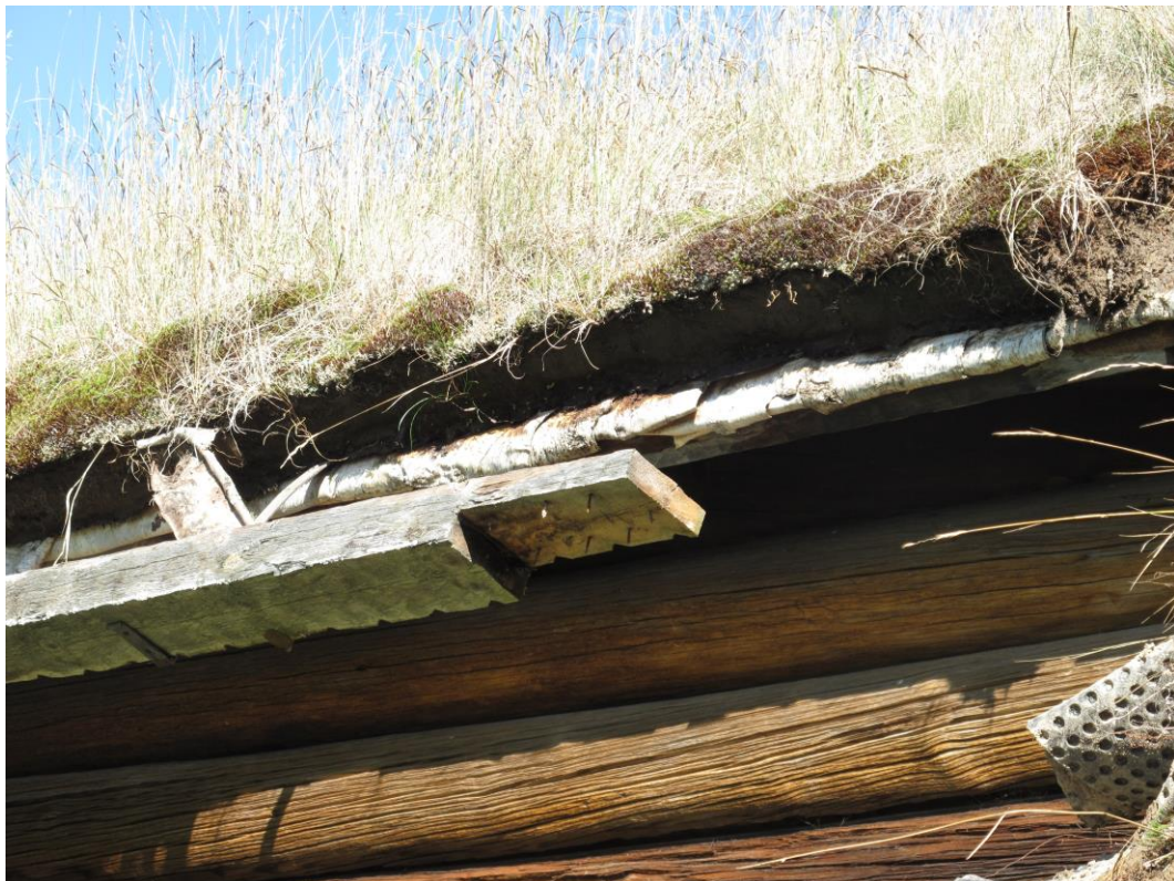
Mullåsen hänger i järnen långt utanför takfoten och sin ursprungliga plats.
