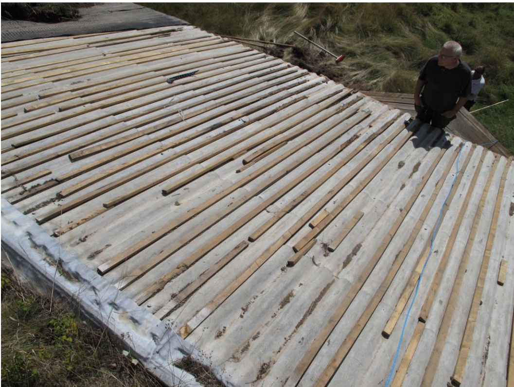
Eternit med tunna slator i vågdalarna för att jämna ut ytan. Ovanpå eterniten ligger platonmatta och ett relativt tjockt torvlager.
