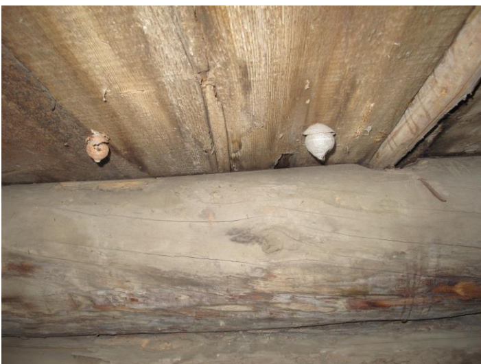
En sparre i undertaket har givits plats genom urtag i översta väggbandet i timmerstommen.
