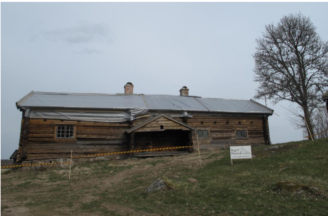
Taket "skalades" av, ner till undertaket av råspont och täcktes med presenningar för vintern.
