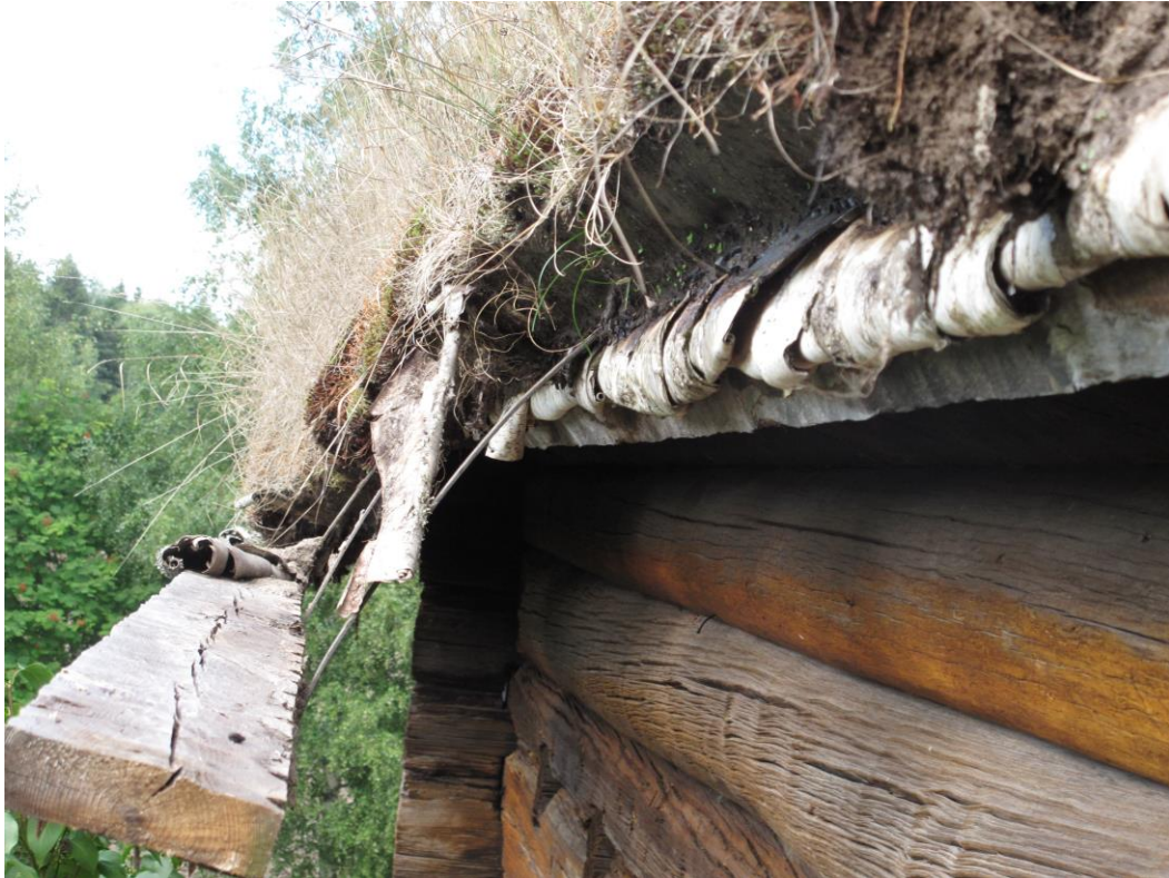
Mullåsen hänger i järnen långt utanför takfoten och sin ursprungliga plats.
