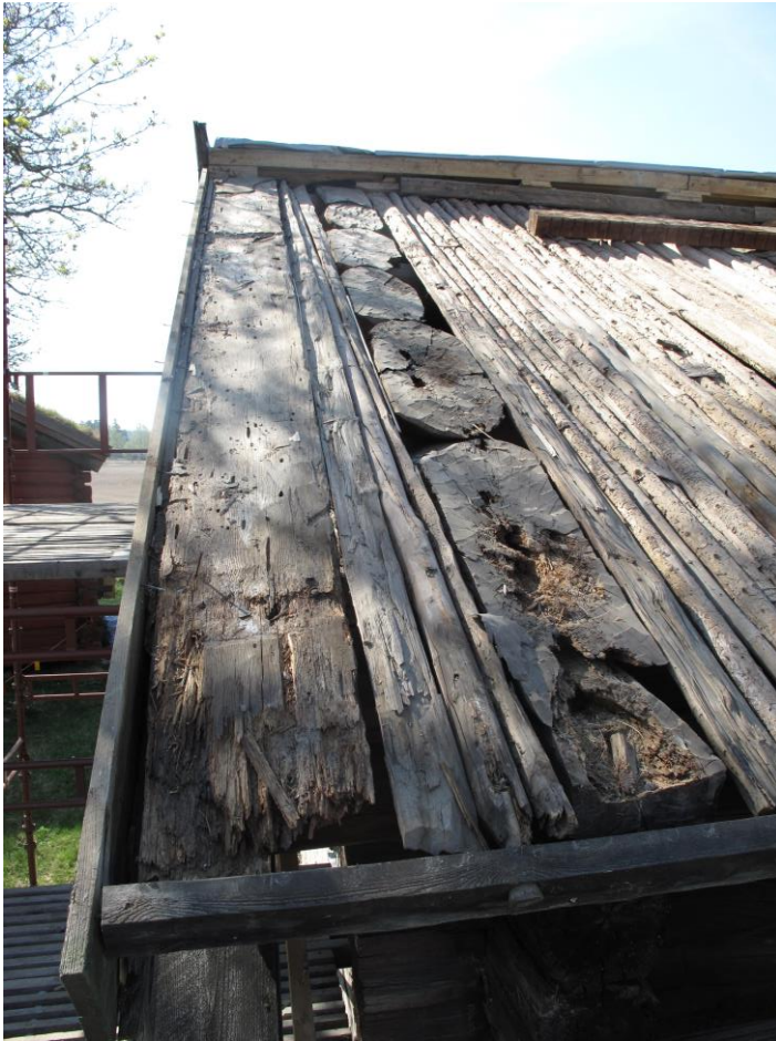
Norra takfallet vid ena gaveln. Gavelröstet av timmer syns mitt i bilden. Längst ut mot takfoten ligger en undertaksbräda i stället för trol, vilken kan vara ursprunglig. I mitten av bilden ses vågbordet som fästs med en dymling i en sparre/trol.
