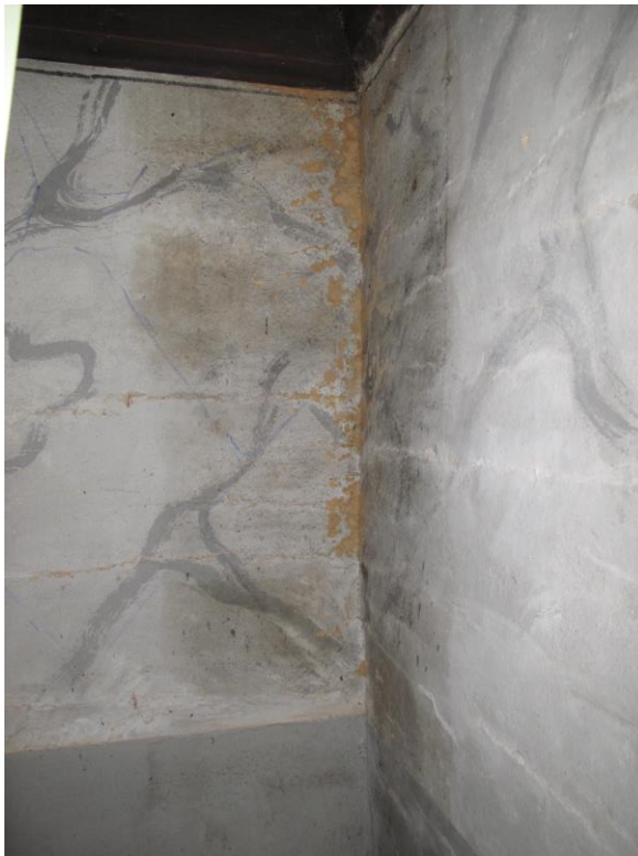
Nordvästra hörnet i västra rummet på nedre våningen.
