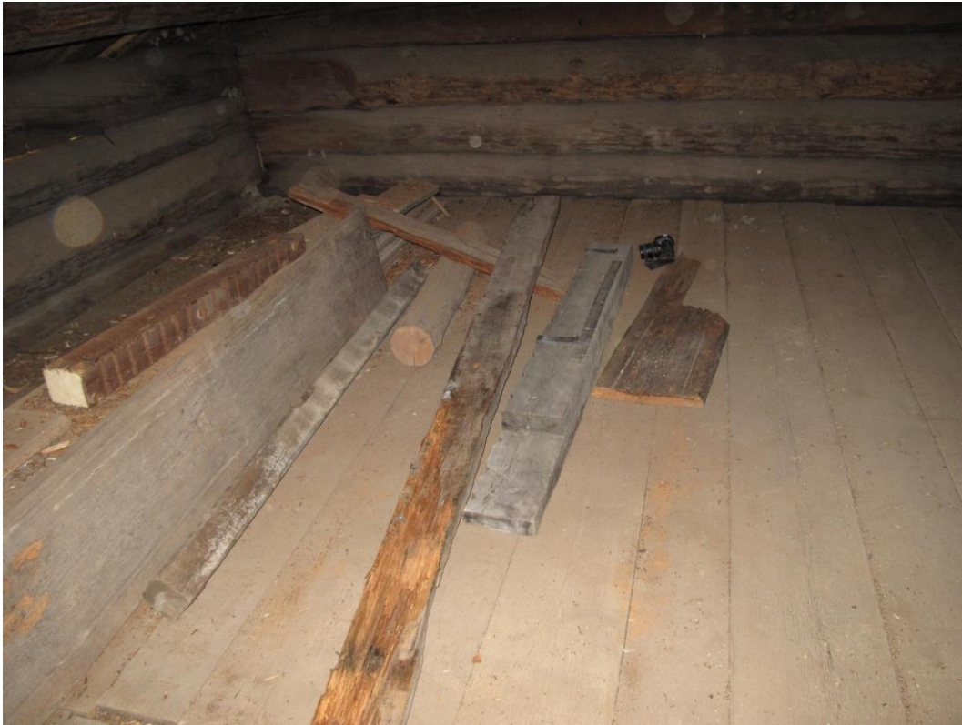
Delar från taket, i olika åldrar, lades i västra vindsrummet som framtida referensmaterial.
