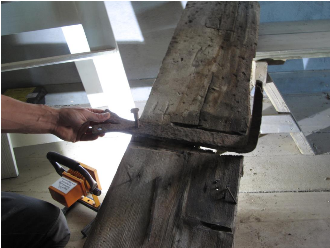
Det äldre vågbordet och järnkroken. Järnkroken var ursprungligen fäst i en sparre som satt mellan järnkroken och vågbordet.
