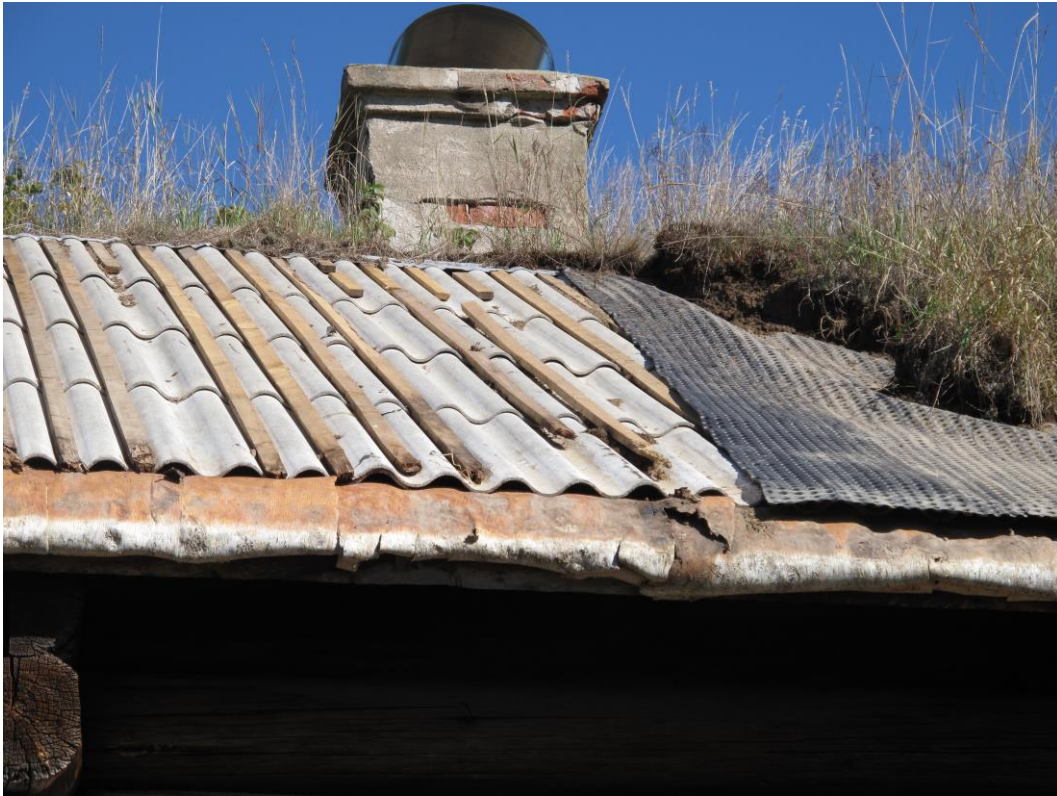
Eternit med tunna slator i vågdalarna för att jämna ut ytan. Ovanpå eterniten ligger platonmatta och ett relativt tjockt torvlager.
