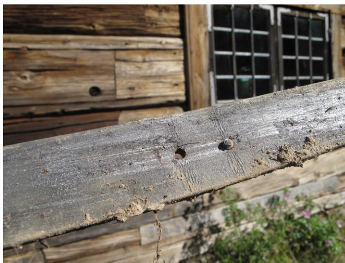
Krokarna som mullåsen var fäst i var skruvade i undertaket. När torven kanade ner från taket har de gått av.
