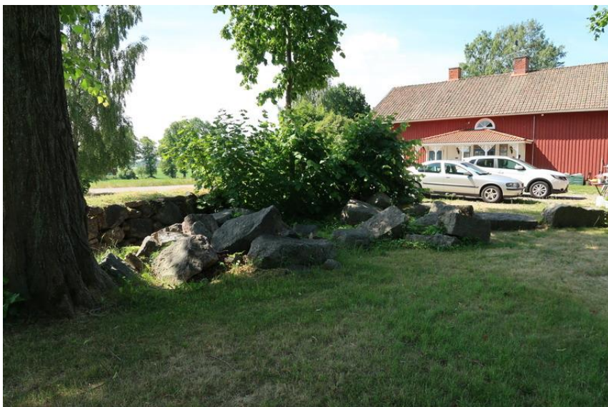
Stenmuren i väster har rasat och kvar finns rester av den. I sydvästra hörnet på kyrkogården finns också en hög med sten som troligtvis kommer från stenmuren.
