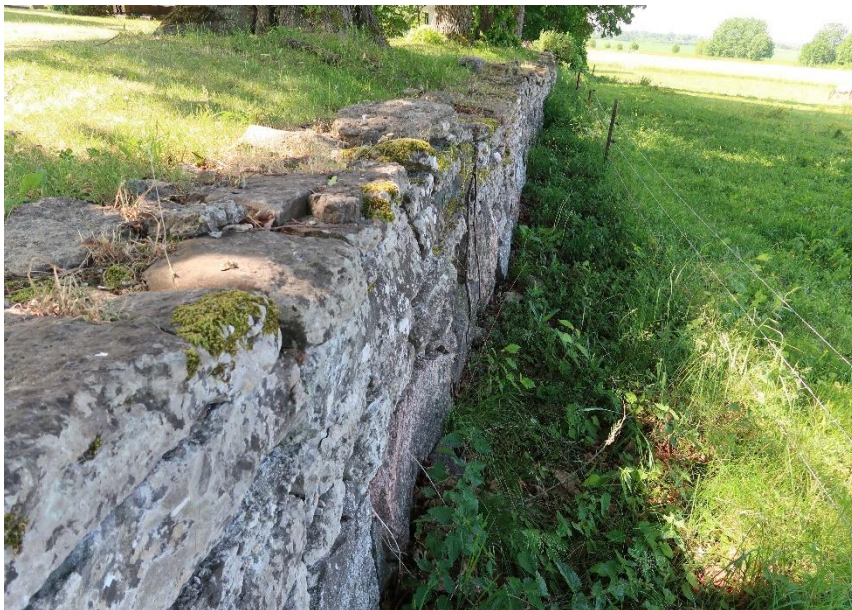
Stenmuren utgörs av en stödmur i norr.
