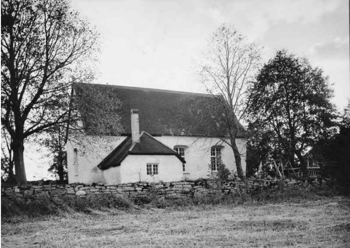
Norra långsidan med sakristian år 1924. Fotograf okänd. Källa: www.raa.se Muren har en annan karaktär än dess södra motsvarighet. Här dominerar kalksten och muren har en stödjande uppgift.
