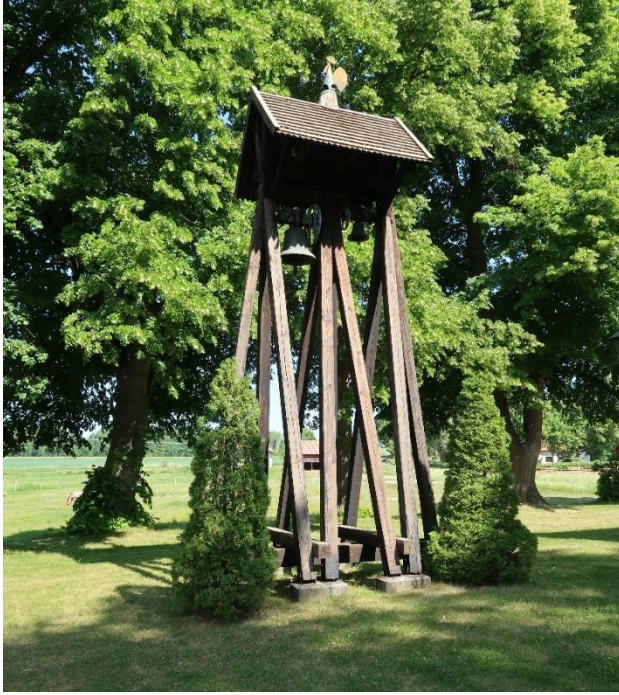
Sentida klockstapel med öppen klockbock med spåntak som kröns av en tupp.
