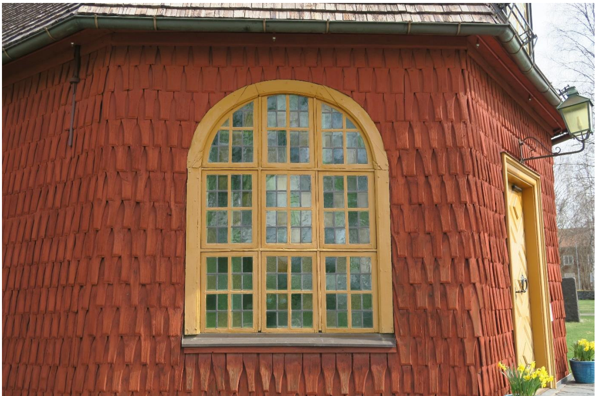
Nya entréer från 1929 samt fönsterbågarna som 1929 förses med blyspröjsat antikglas.
