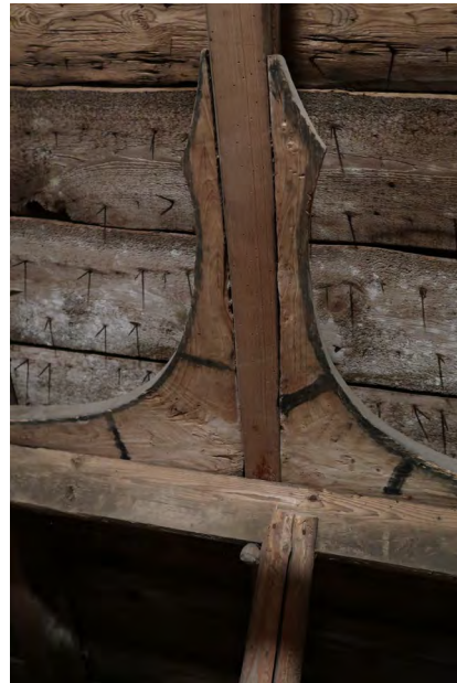
Mellan de äldsta takstolarna sitter dekorativt utformade bågknän med dekorativt måleri i svart, rött och vitt. Taklaget var synligt för gudstjänstbesökarna innan långhuset försågs med ett innertak.
