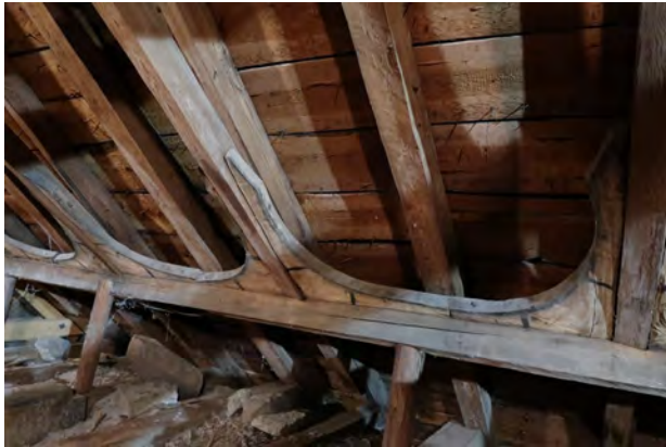
Mellan de äldsta takstolarna sitter dekorativt utformade bågknän med dekorativt måleri i svart, rött och vitt. Taklaget var synligt för gudstjänstbesökarna innan långhuset försågs med ett innertak.
