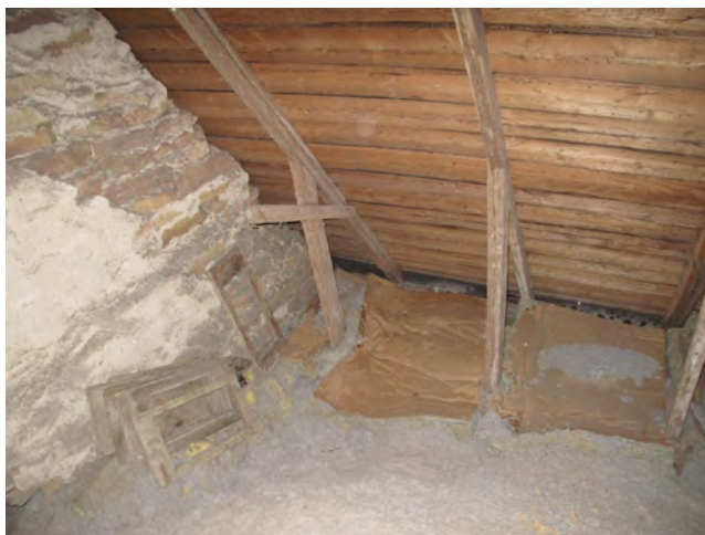
Nord östra hörnet på vinden med kyrkans östra gavelspets till vänster i bild. Där syns även det putsade partiet som avslöjar det tidigare tunnvalvets form samt en av stödbjälkarna som sticker ut från takstolen.
