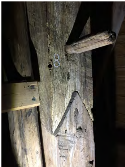
Prov 8 taget i hjärtstockens övre halva i ek, precis intill skarven
