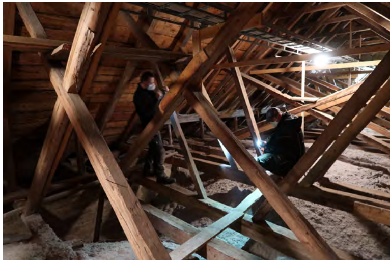
Taklaget i Knista kyrka undersöks för att hitta lämpliga ställen att kunna ta dendrokronologiska prover.
