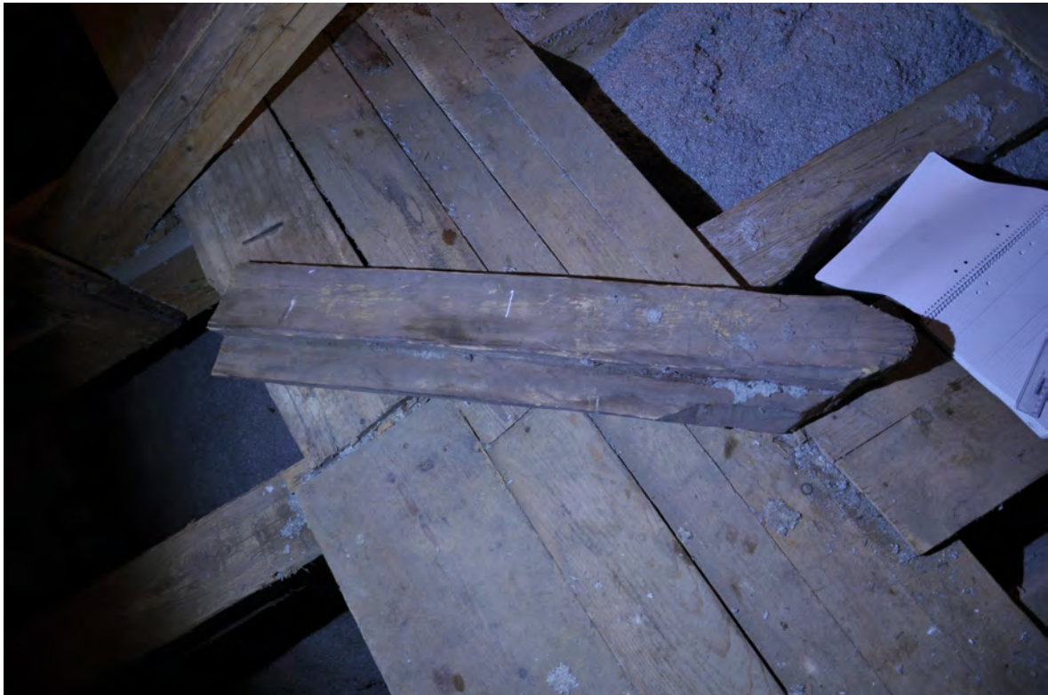
Prov 1 består av en sedan tidigare avsågad del av taklagets längdförsträvning. Biten som är av gran gav dessvärre ingen datering.
