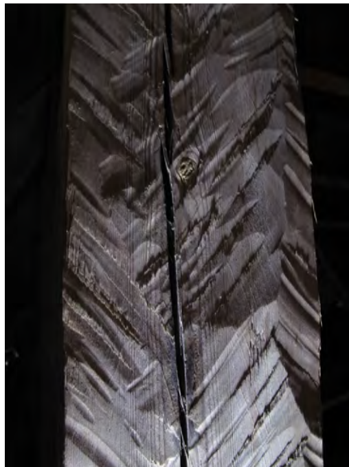
Takstol med sprätthuggen yta som bildar det karakteristiska fiskbensliknande mönstret. Det var vanligt på bearbetat virke under tidig medeltid.
