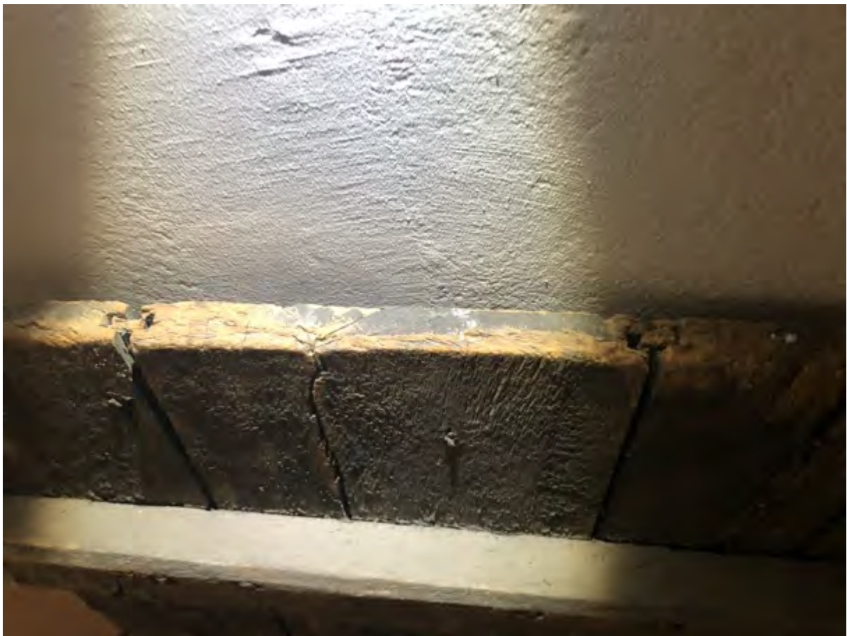
Dörren fotad uppifrån. Brädan i mitten innehåller märe vilket tyder på att den är sågad, inte handkluven. Man ser också notspåren med lösa fjädrar.
