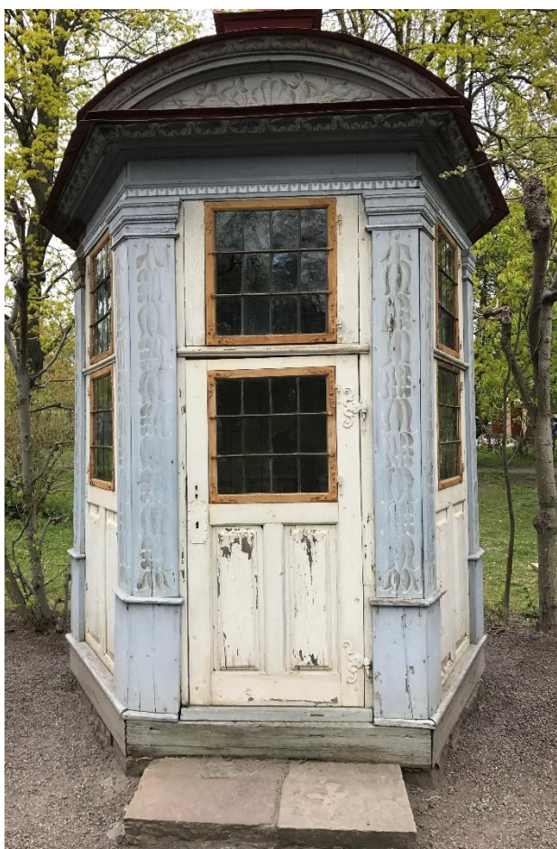
T.v. Figur 7. Främre fasad mot söder och köksträdgård. Uppvisar allmänt färgbortfall, sprickor och krackelering. T.h. Figur 8. Fasad mot öster.
