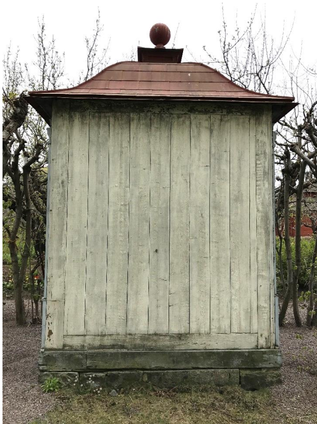
T.v. Figur 9. Fasad mot norr. Algpåväxt på panel och takplåt samt slitna färgskikt.
