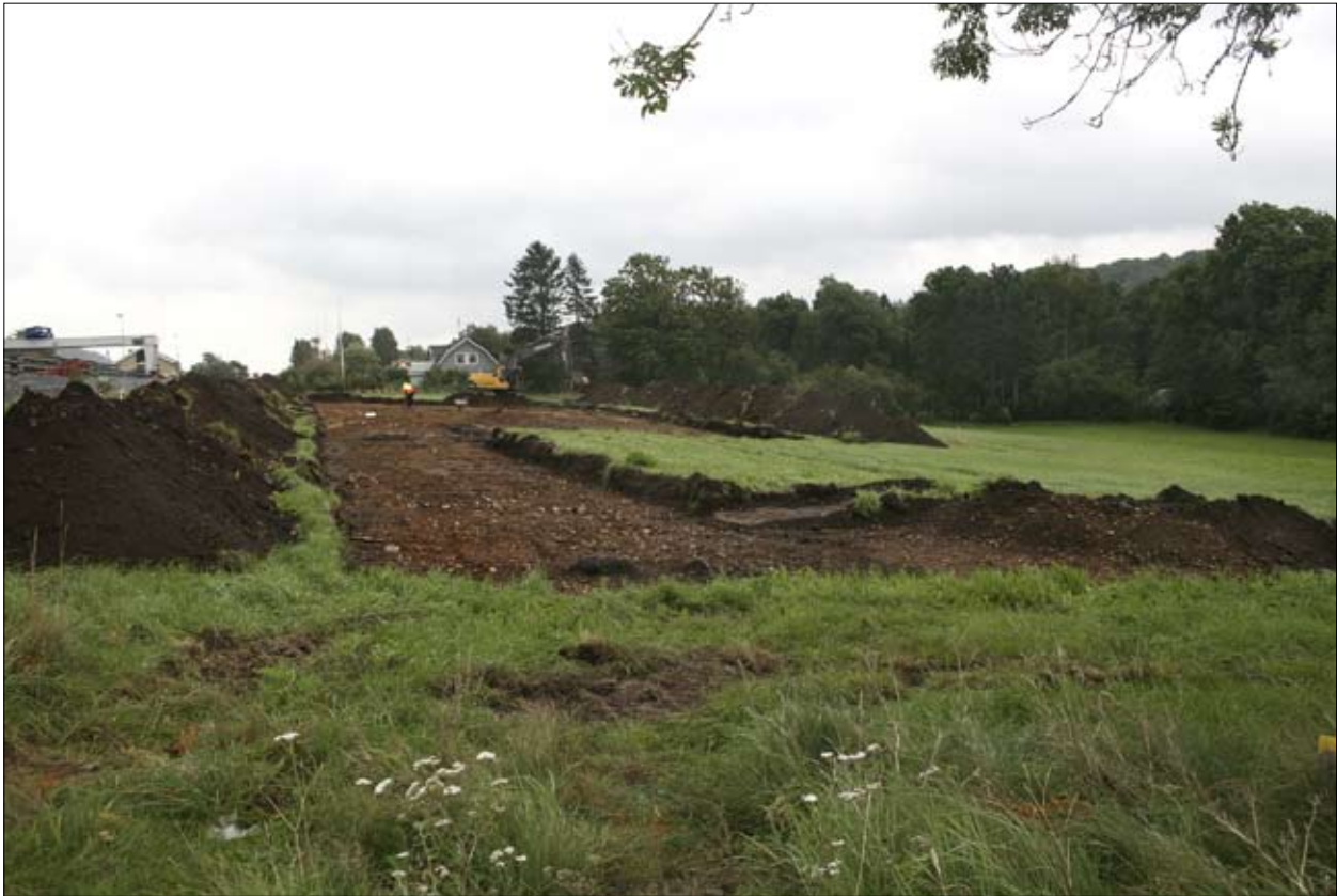
Figur 48. Den påbörjade schaktningen, sedd från sydväst. Foto: Bengt Westergaard.
