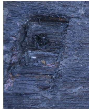
Figur 32: Eksempel på avtrykk etter roe på hudbord x180. Foto av Kristina Steen, NMM.
