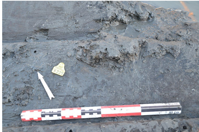
Figur 30. Eksempel på rester av korrosjon etter roer og spiker som har festet hudbordene sammen. Foto av Kristina Steen
