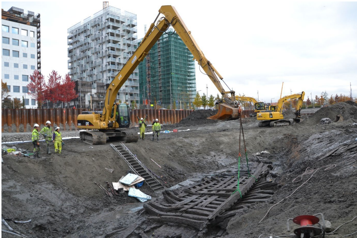
Figur 6. Opptak av kjølsvin med hjelp av gravemaskin. Foto av Kristina Steen, NMM
