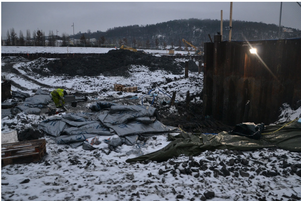
Figur 6: Vinterlige forhold under utgravningen av Bispevika 8. Foto av Kristina Steen, NMM.
