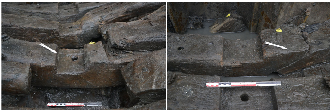
Figur 48: Til venstre: eksempel på vertikal skrålask mellom bunnstokk x050 og opplenger x066. Foto tatt mot SSV. Til høyre: eksempel på vertikal skrålask mellom bunnstokk x047 og opplenger x062. Foto tatt mot SV av Marja-Liisa P. Grue, NMM.
