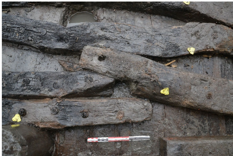
Figur 50: Lask mellom bunnstokk x049 og opplenger x065. Foto tatt mot NØ av Marja-Liisa P. Grue, NMM.
