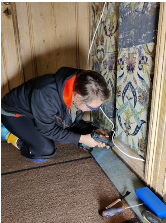
Demontering av plater av blikk på Lysøen
