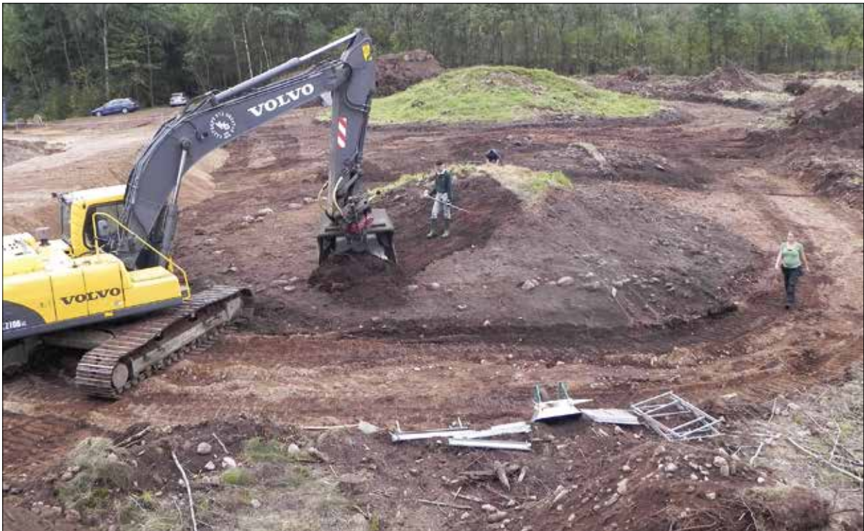
Figur 5. Matjordsavbaning av den norra högen. Foto: Tore Artelius.
