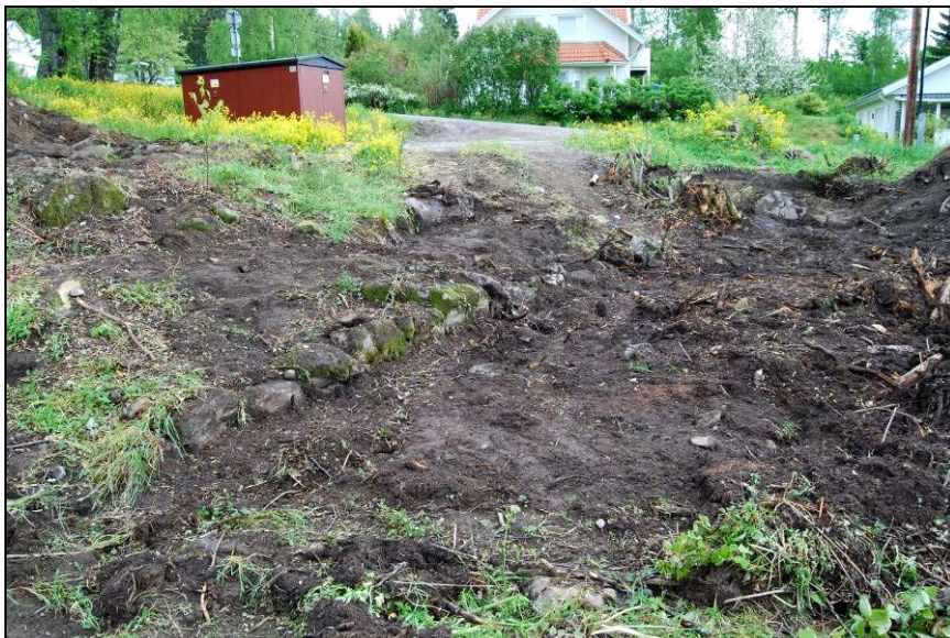
Foto 2. Schakt 7 med stenkanten/grunden Till vänster i bildens övre del syns nedre delen av lobryggan från SV.
