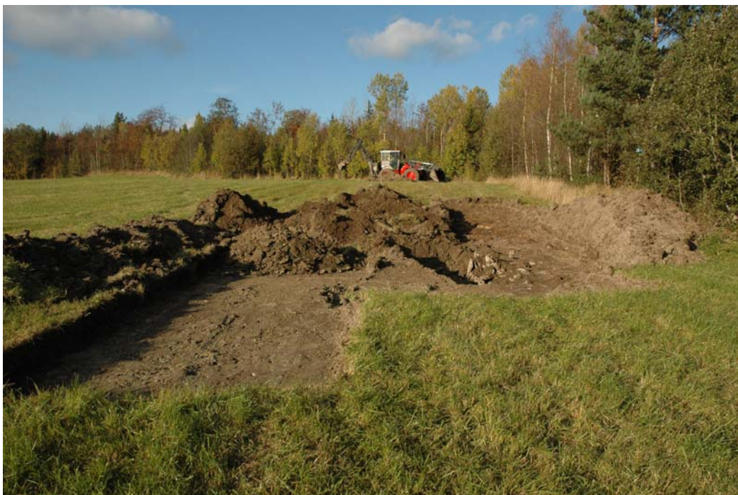
Schakt vid Skrängsta i trakten av Myre. Foto från syd.
