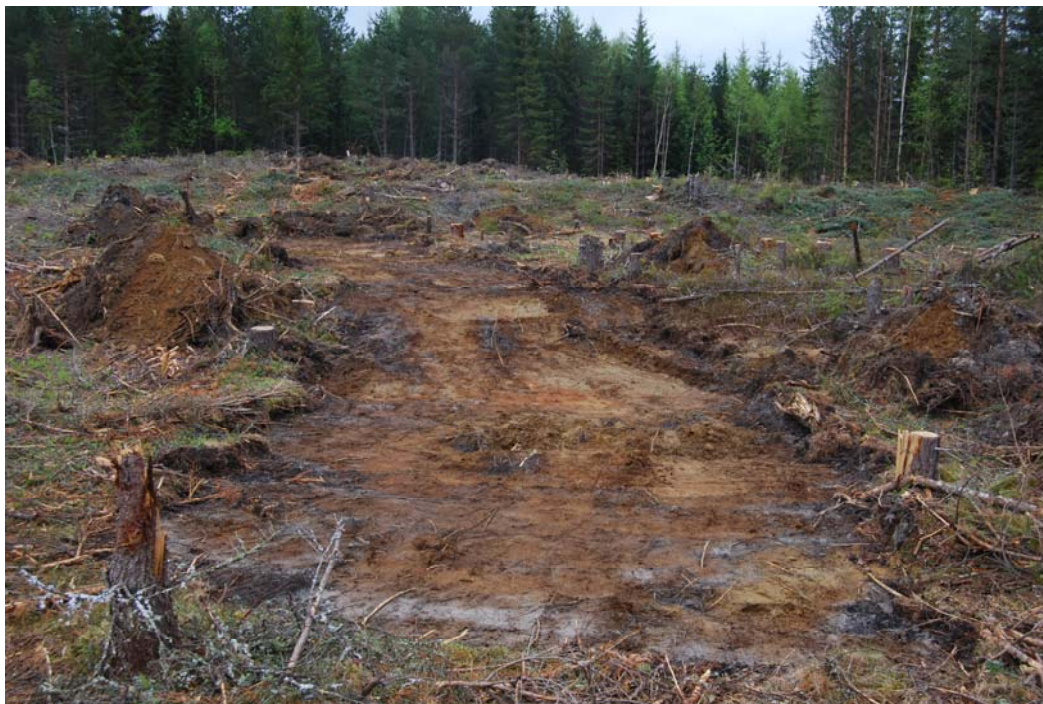
Schakt vid Dingersjömon. Foto från syd.
