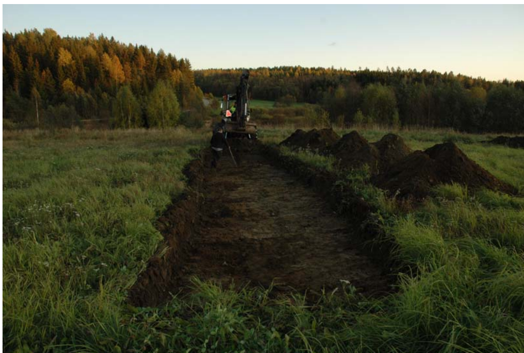
Schakt vid Åmon. Foto från norr.
