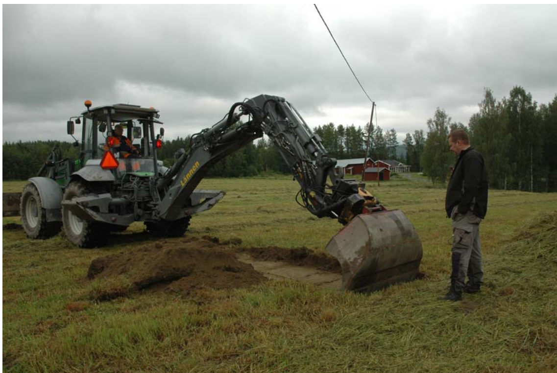
Schaktning i Dals-Årsta.
