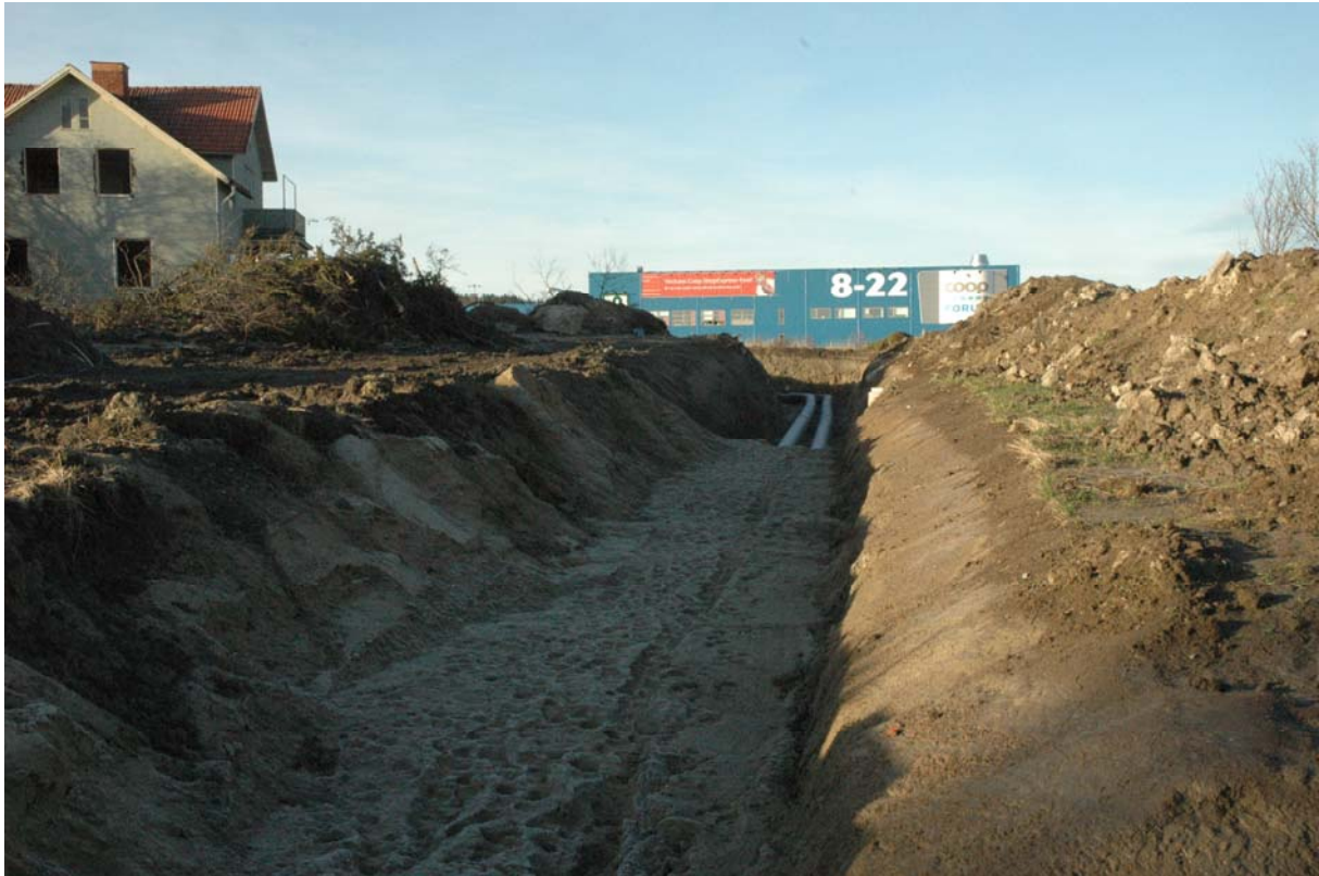
Fig. 43. Rören för fjärrvärmen har lagts ned och vintern är på intåg.
