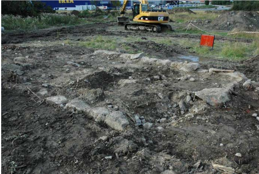
Fig. 17. Den västra delen av stenmuren efter rivning av huset och betongplattan. Foto från SÖ. Framför denna grund – i bildens nedre vänstra hörn – hittades vid utredningen en stenpackning och fynd av kritpipsfragment och rödgods.
