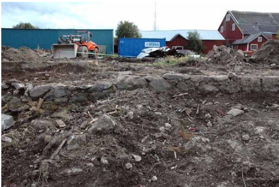
Fig. 18. Skillnaden på stenar och i stengrunden tyder på att grunden har två faser. Den vänstra delens stengrund har varit högre, de övre stenarna satt fast i betongen och följde med vid rivning av denna. I förgrunden syns röset. Det består av ett flertal större stenar i botten och mindre plocksten blandat med grus. Foto från norr.
