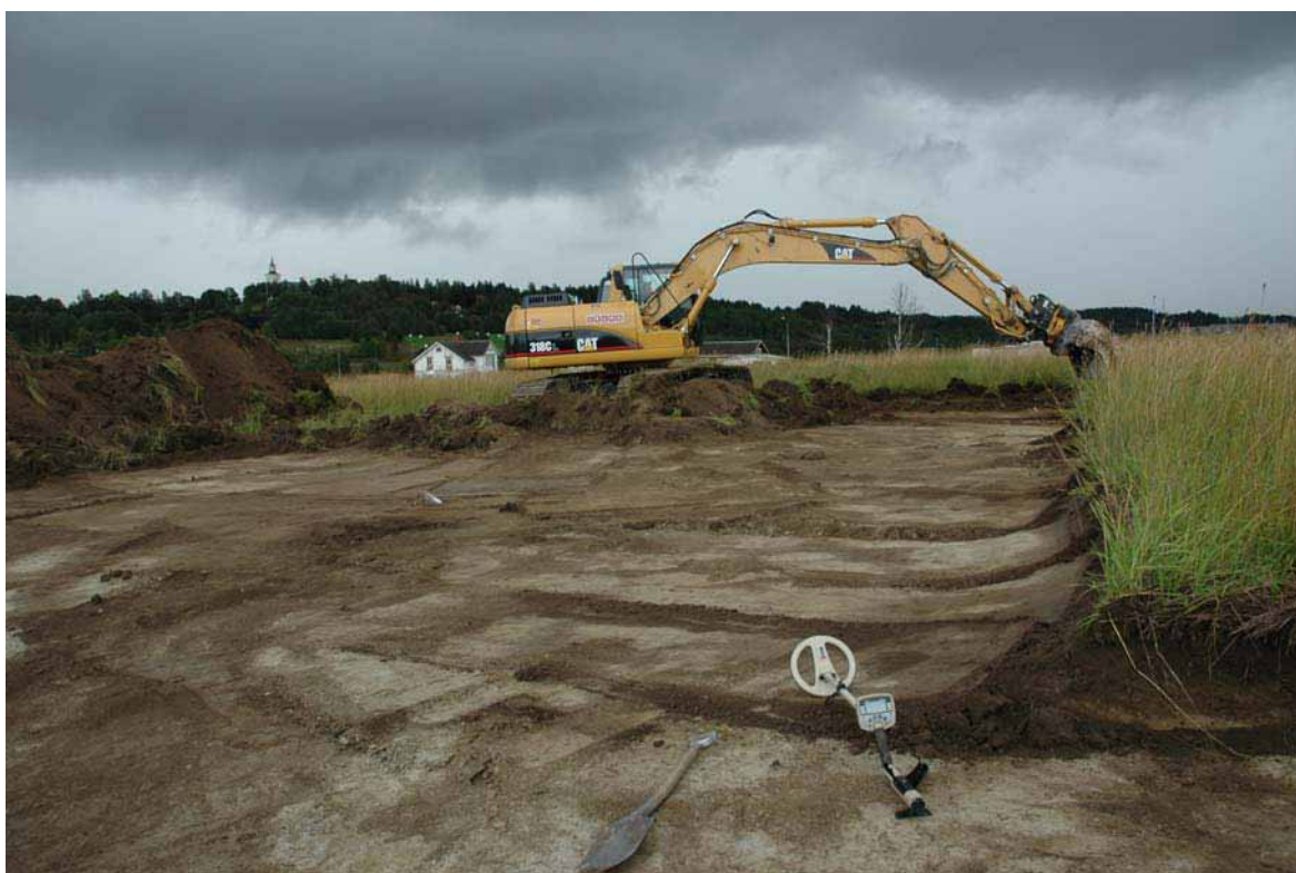
Fig. 8. Avbaning av den nordöstra delen av fjärrvärmeschaktet.
