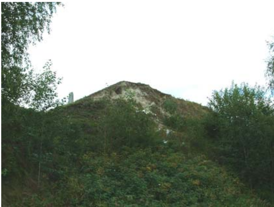
Erosionsskador på sydöstra hörnet av Styresholms norra platå. Fotot taget från Sydöst.
