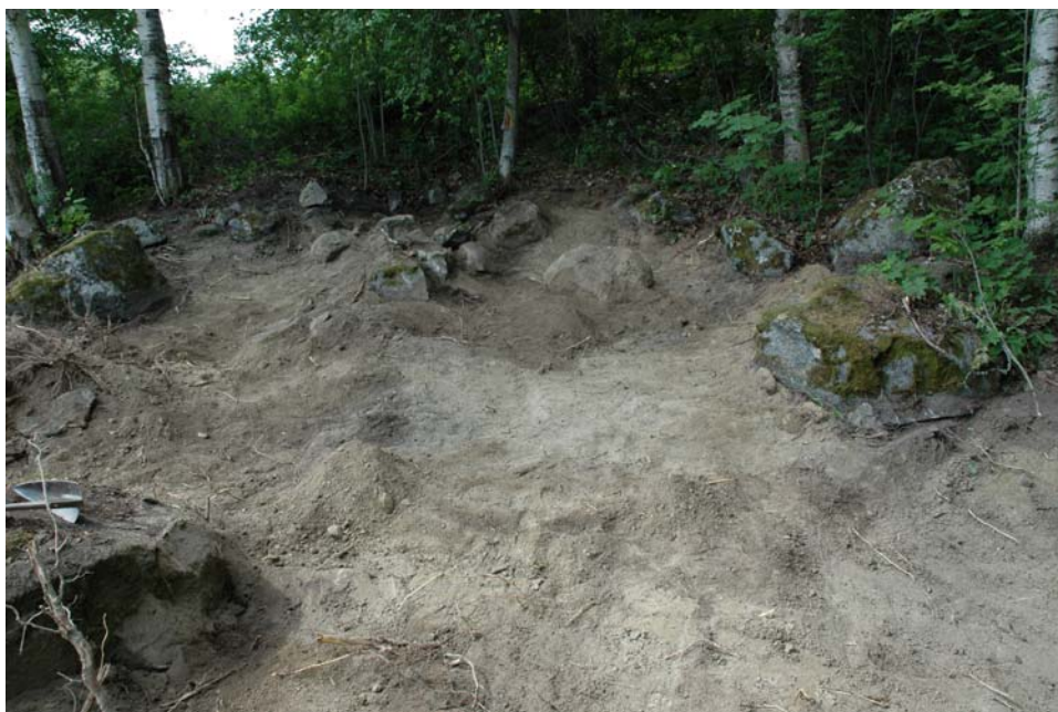
Ytan där det planerade garaget skall stå.
