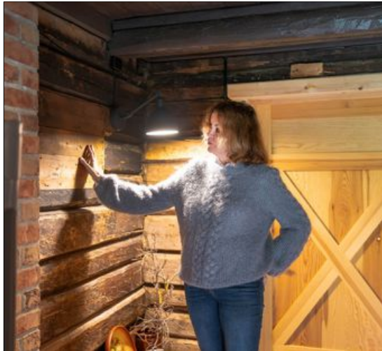
NYTT: Noen stokker var morkne og måtte byttes ut, men Astrid og Jan valgte å beholde så mye som mulig og kun fjerne det som var dårlig.
