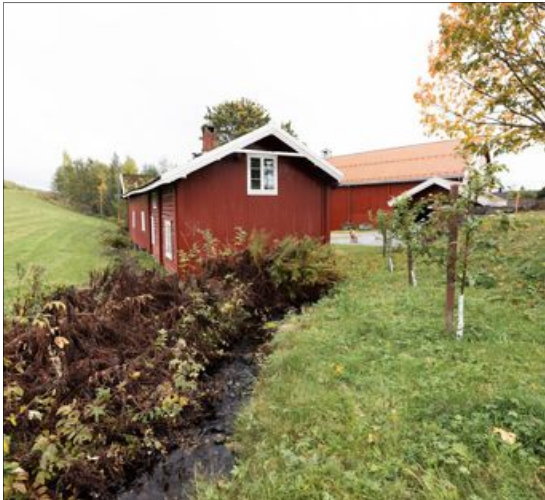
BEKK: Bekken renner gjennom bryggerhuset.
