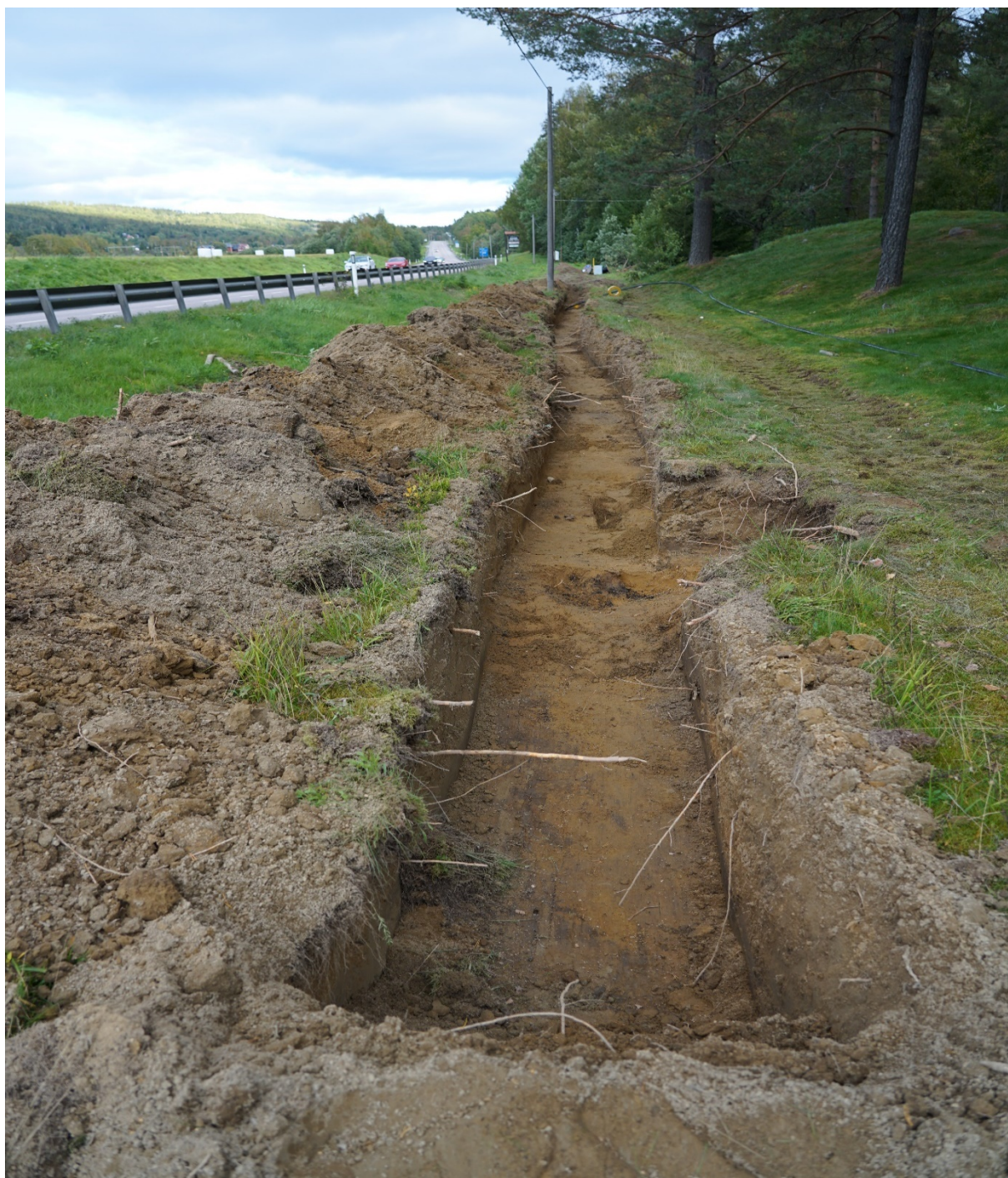
Fig.10. Schakt 3. Foto från väst.
