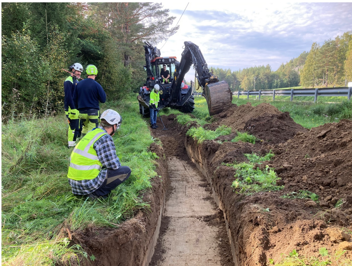
Fig. 6. Schakt 1 första dagen i Starkotter, foto från öst.
