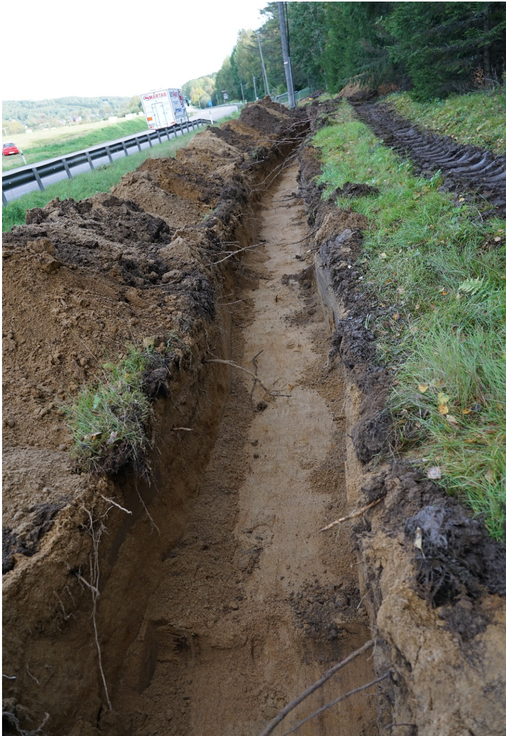
Fig. 28. Schakt 6. Foto från väst.
