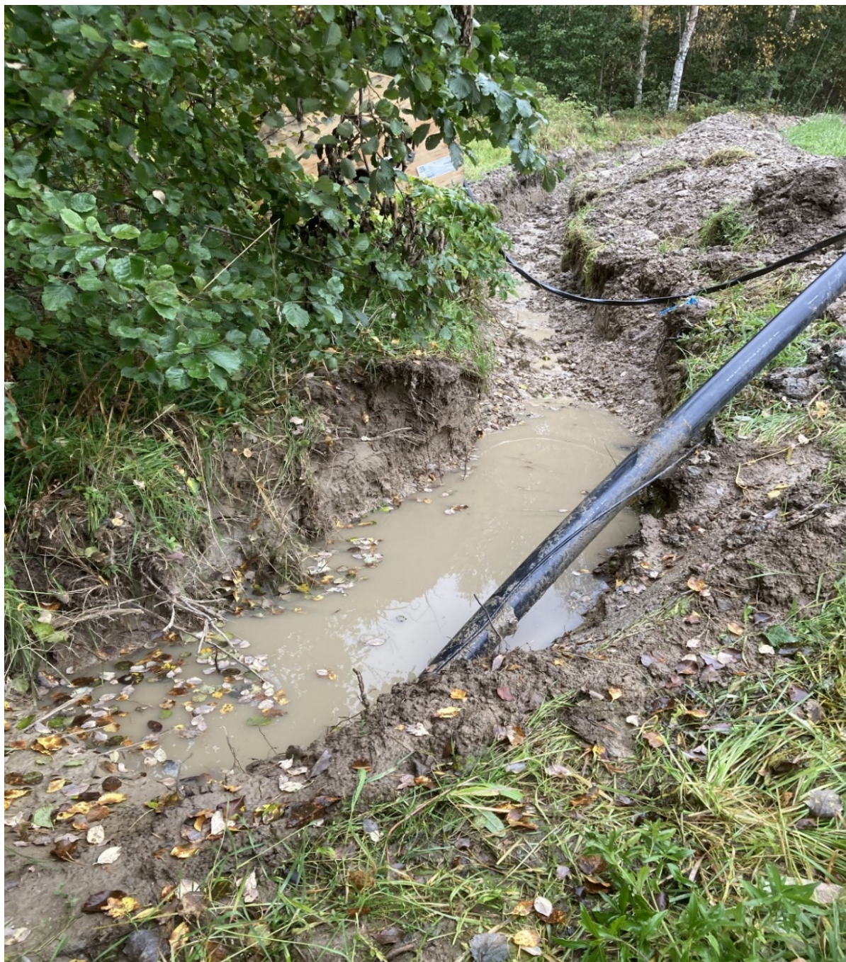
Fig. 34. Schakt 10 närmast E14. Vattenfyllt schakt på grund av regn. Foto från sydöst.
