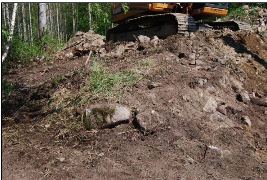
Fig. 17. Borttagande av massor på Raä 59. Rösets västra kant, några av stenarna syntes även innan dumpmassorna togs bort. Foto mot öster.
