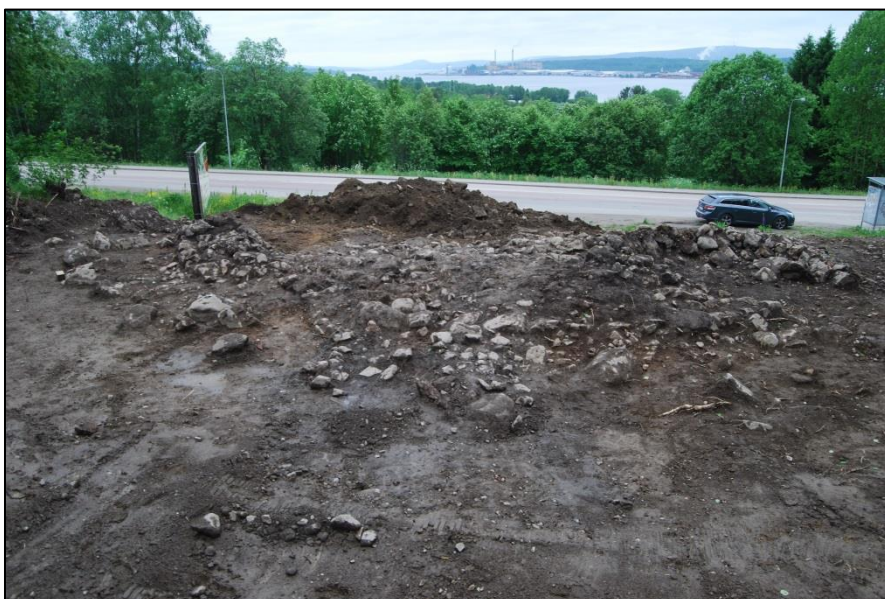
Fig. 23. Grovrensats. Foto mot söder.
