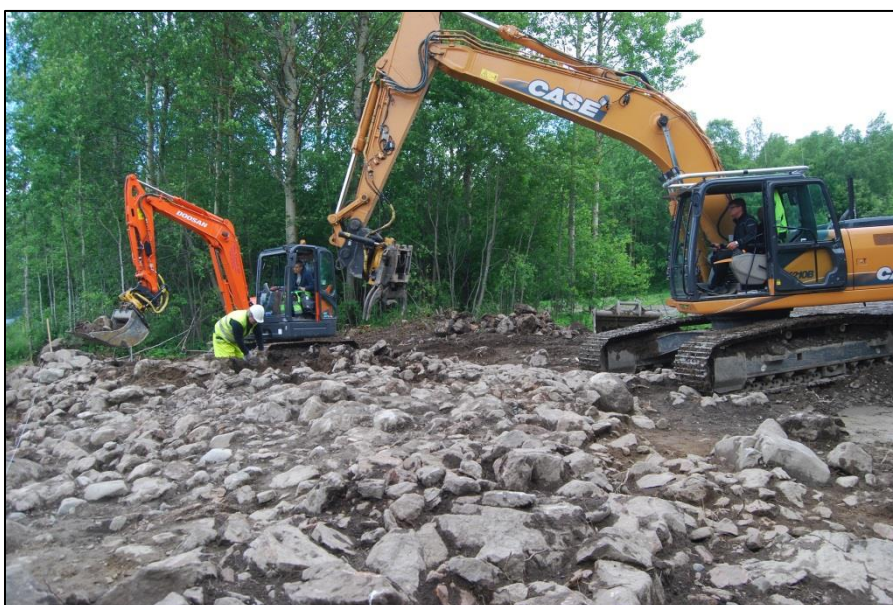
Fig. 31. Stenlyft med hjälp av grävmaskiner i olika format.
