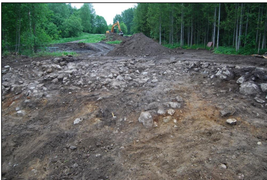
Fig. 21. Dumpervägen och tydlig kant i söder där graven schaktats bort. Foto mot N.
