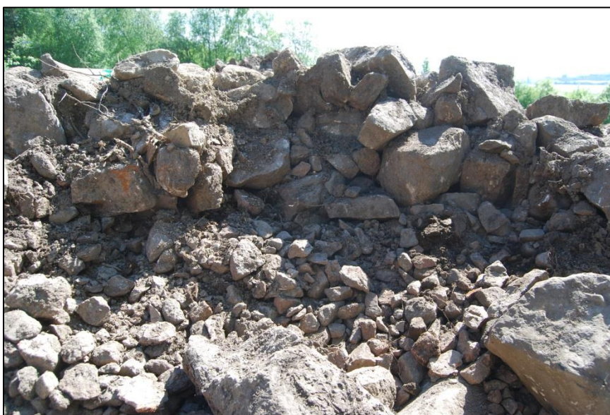
Fig. 20. Skadan som reparerades 1939, delvis urgröpt på fyllnadsmassor. Foto mot SV.
