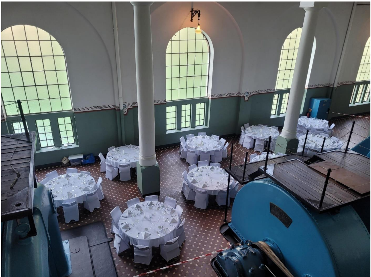
Tysso I kraftstasjon pynta til fest. Foto: Åsne Dolve Meyer, Kraftmuseet
