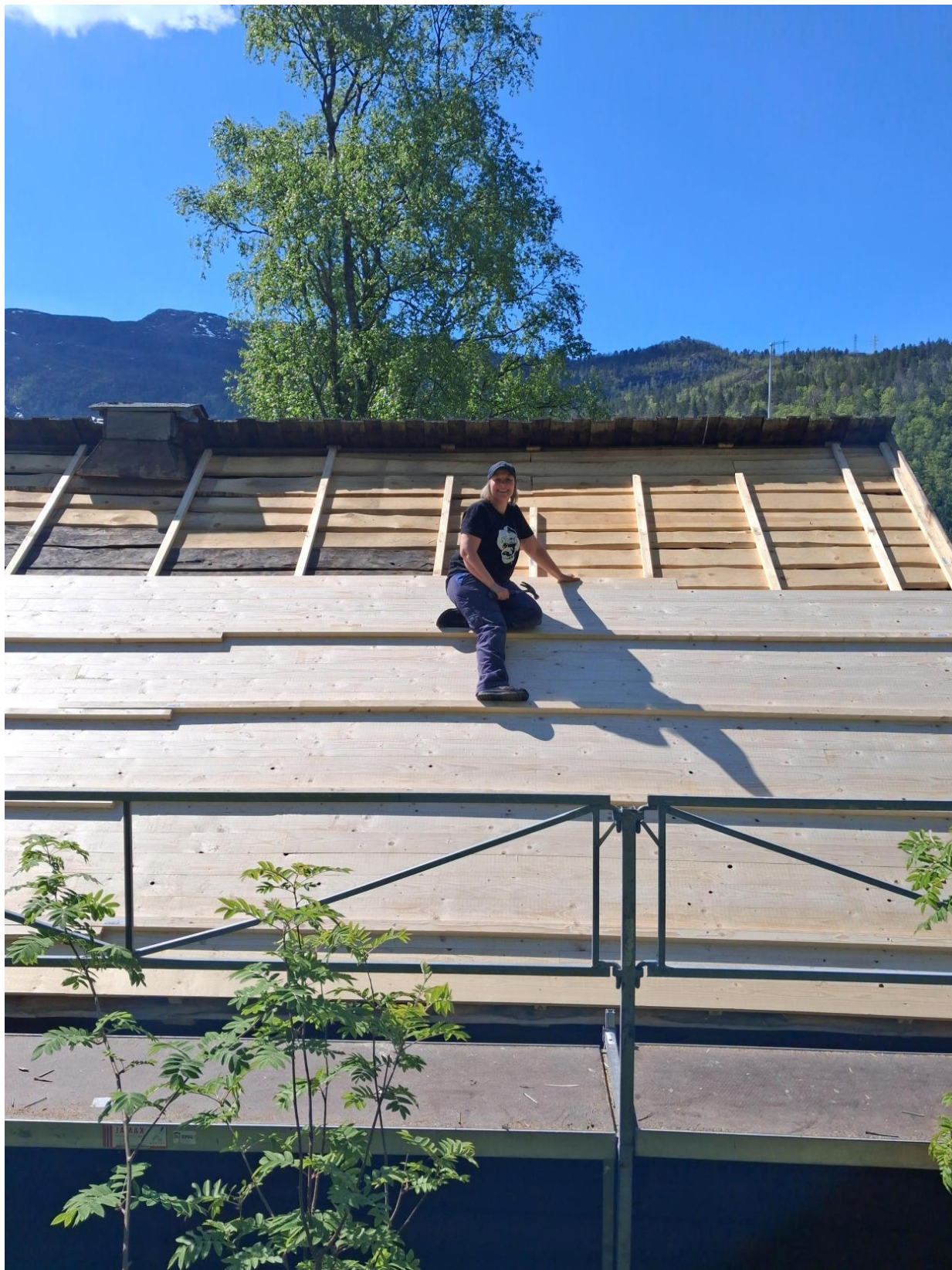
Takarbeid på Skjeggedalstova. Foto: Kraftmuseet / Frode Bu
