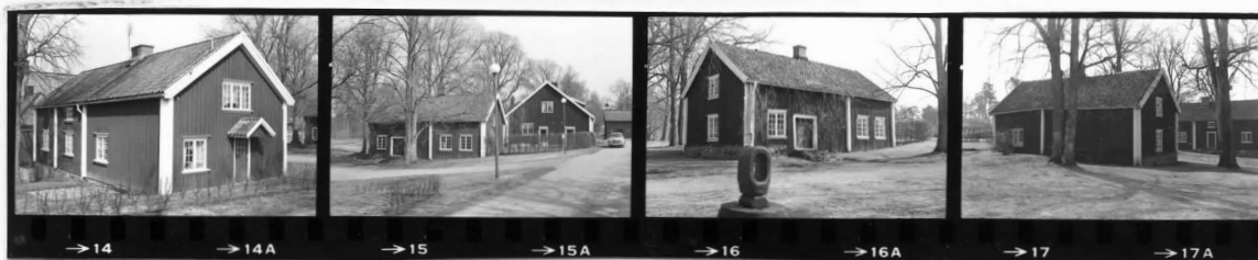
Hus 81 OSO Hus 82, 86 S Hus 82 SV Hus 82, 81 N
