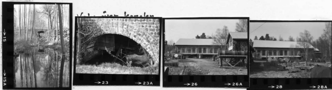
Bron NO om hus 180 från SO Hus 180,181 S Hus 180 S
