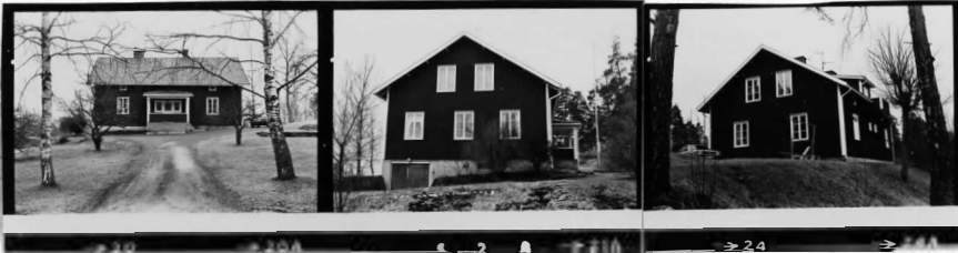
Hus 14 VNV Hus 14 NNO Hus 14 S
