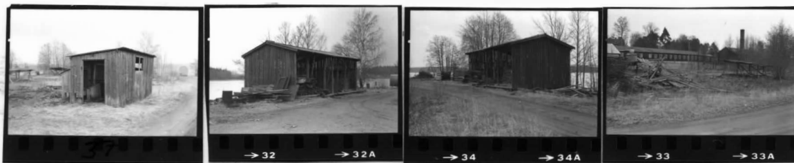
Hus 78 NNV Hus 79 ONO Hus 79 VNV Brädgårdsplatsen SV
