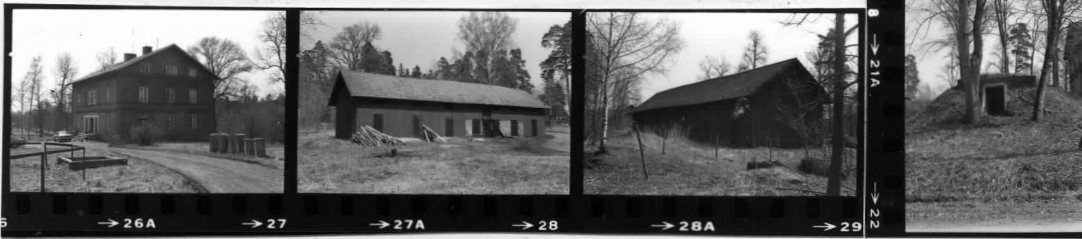
Hus 157 NNO Hus 158 SSV Hus 158 NV Hus 159 V
