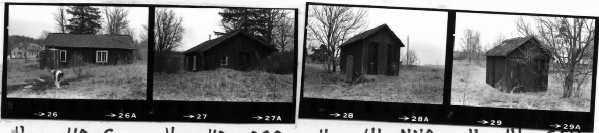
→26 →26A →27 →27A →28 →28A →29 →29A Hus 40 S Hus 40 OSO Hus 41 NNO Hus 41 SSV
