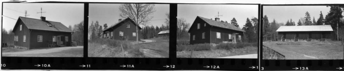
Hus 151 NO Hus 151 SO Hus 151 V Hus 152 SV
