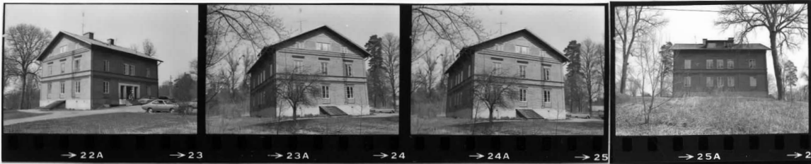
Hus 157 SO Hus 157 SSV Hus 157 SSV Hus 157 V
