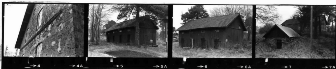
Hus 32 NO Hus 33 SV Hus 33 ONO Hus 34,32 SO
