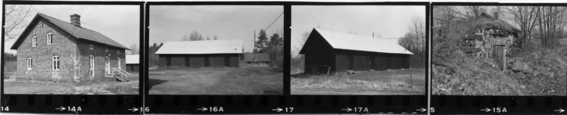
Hus 138 SO Hus 139 SSO Hus 139 SV Hus 140 SO
