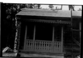
I Detalj Veranda
