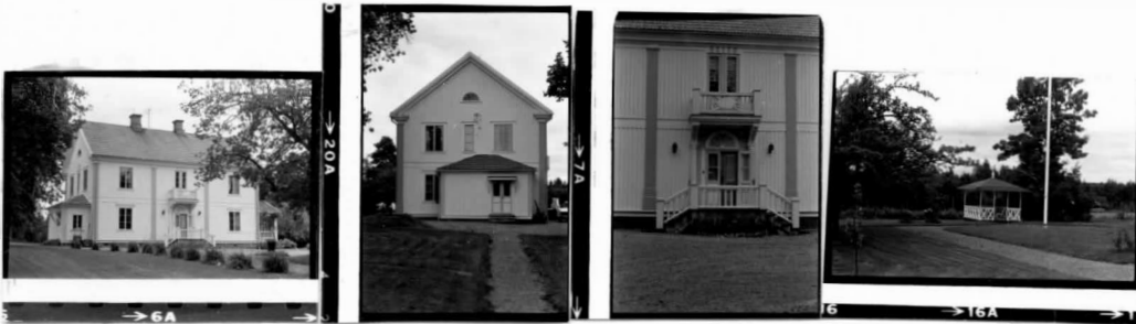
→6A →7A →16 →16A → I NO I SO I Detalj av trappa II SO
