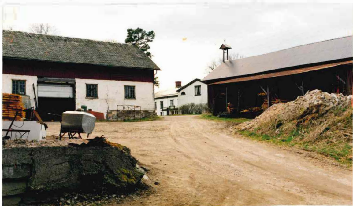
Ekonomibyggnader med vällingklocka och skiffertak
