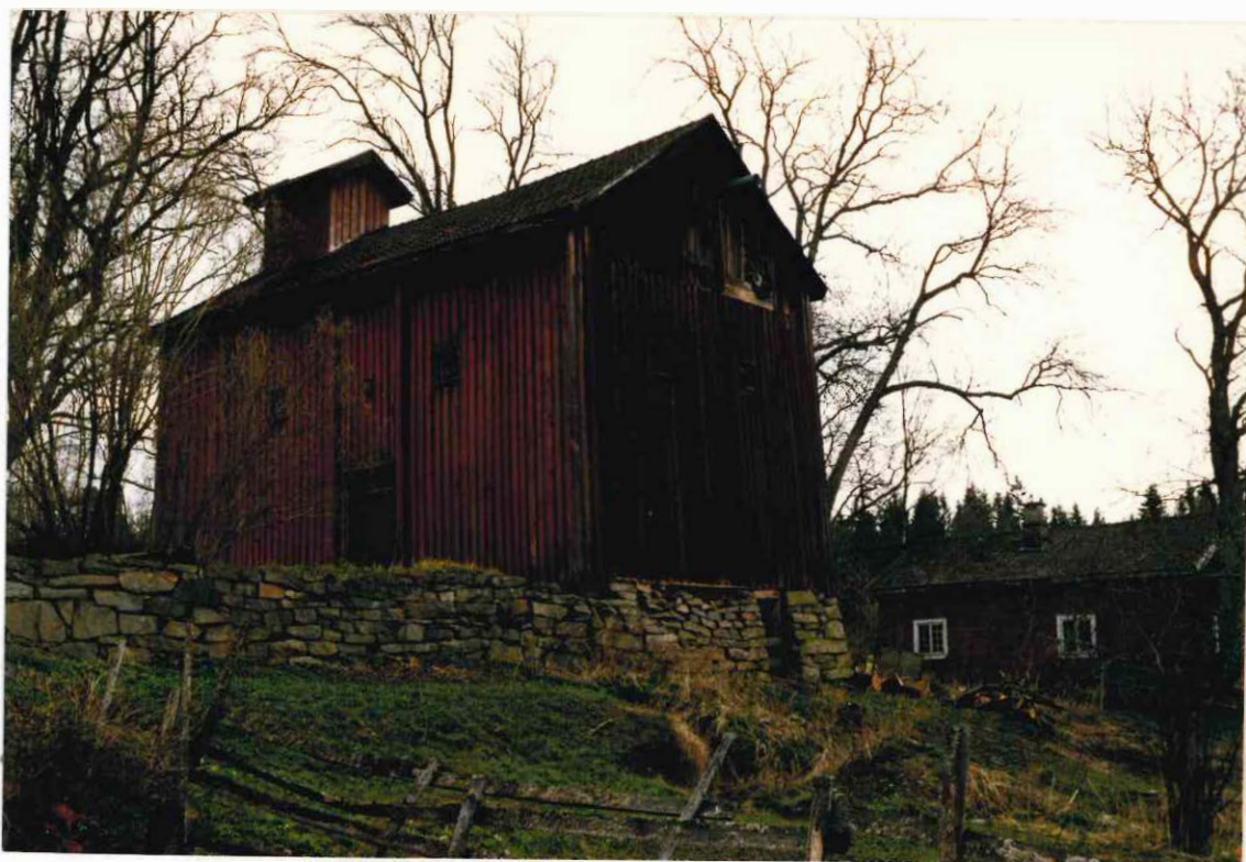
Spannmålsmagasinet med dess påbyggnad för elevator. På hösten sjunker huset ihop 15 cm pga all säd m.m, och fram emot våren höjs det till det normala allt eftersom huset tömms
