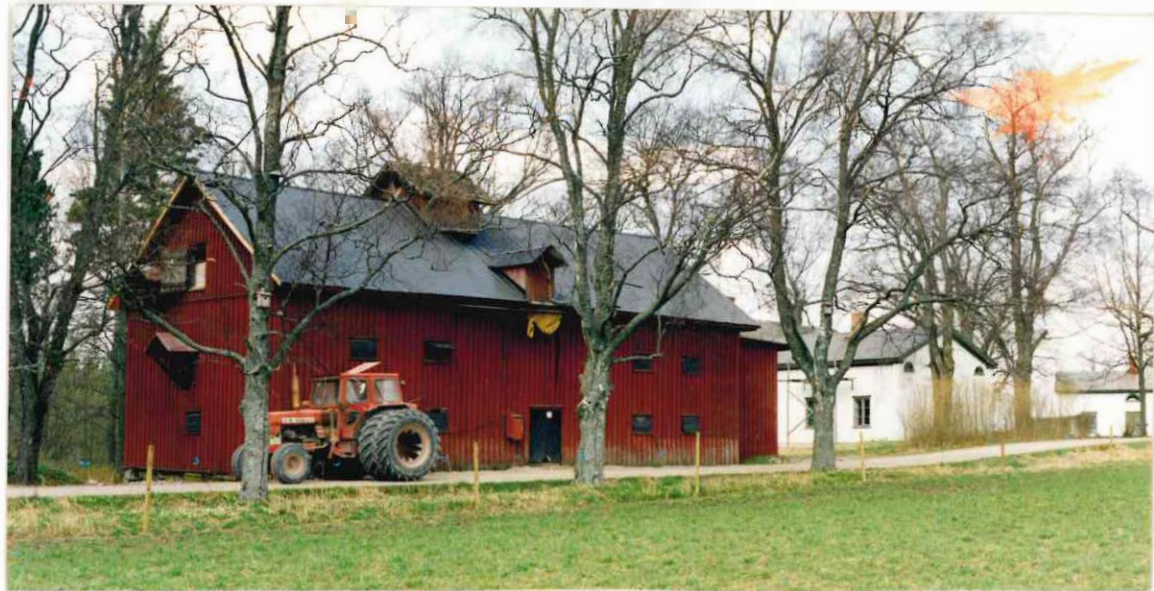
Sädesmagasinet med skiffertaket utbytt mot ekonomiplåt
