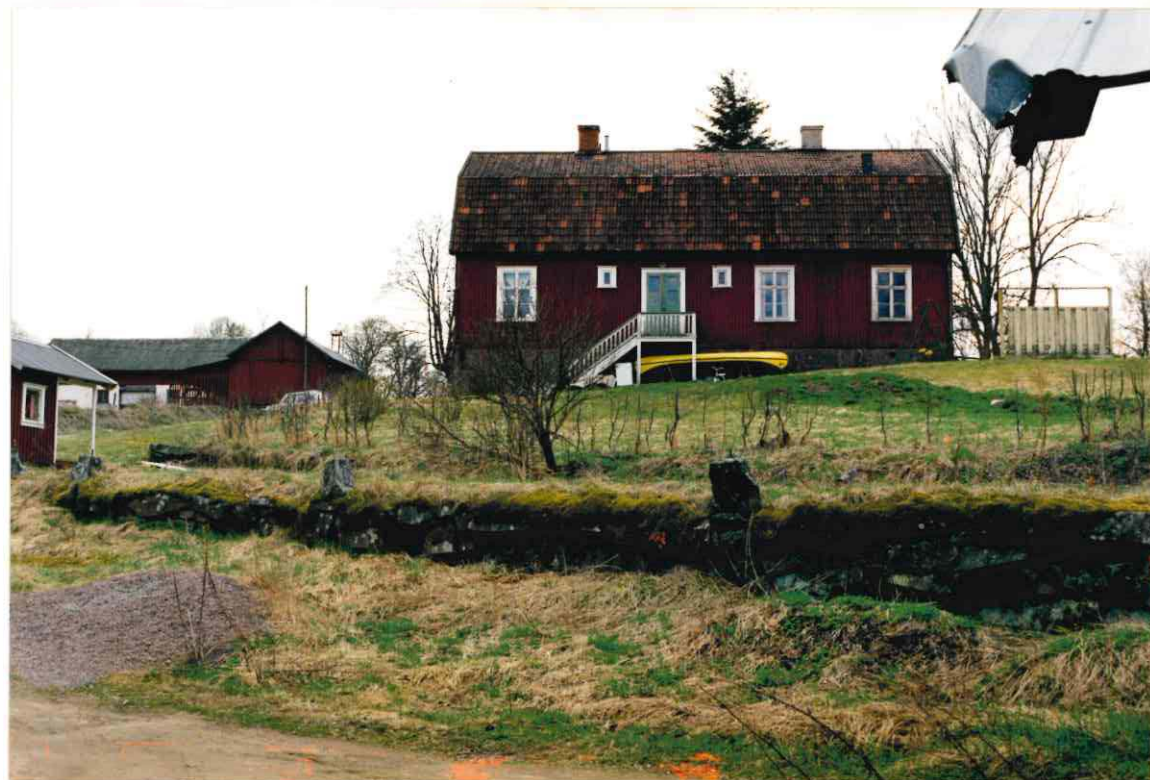
Framsidan på huset är nyligen nypanelad+tillägs-isolerad med 5 cm mineralull. Baksidan återstår dock
