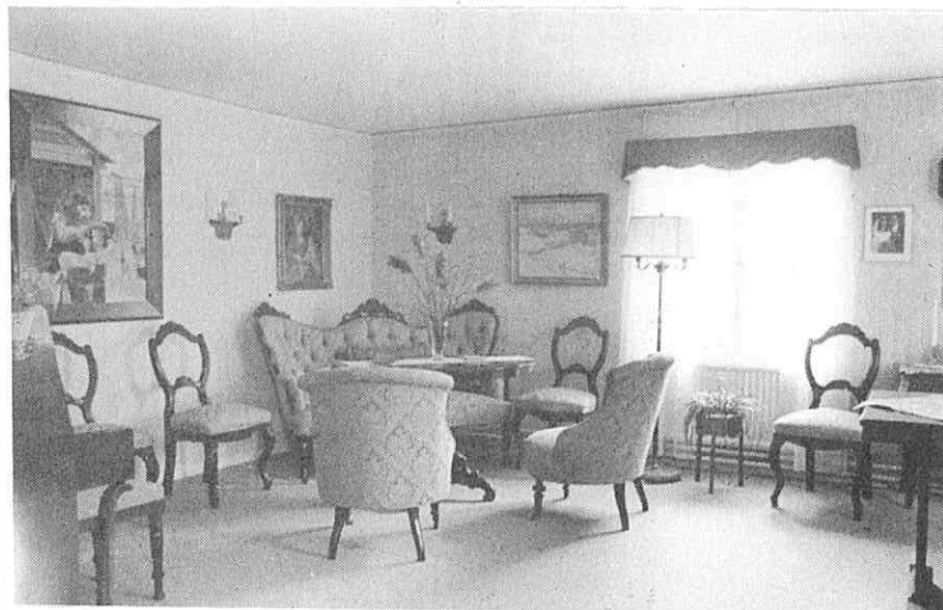
Finrum. Nålfilt på golvet, tapet på väggarna och vitmålad spänd papp i taket.
