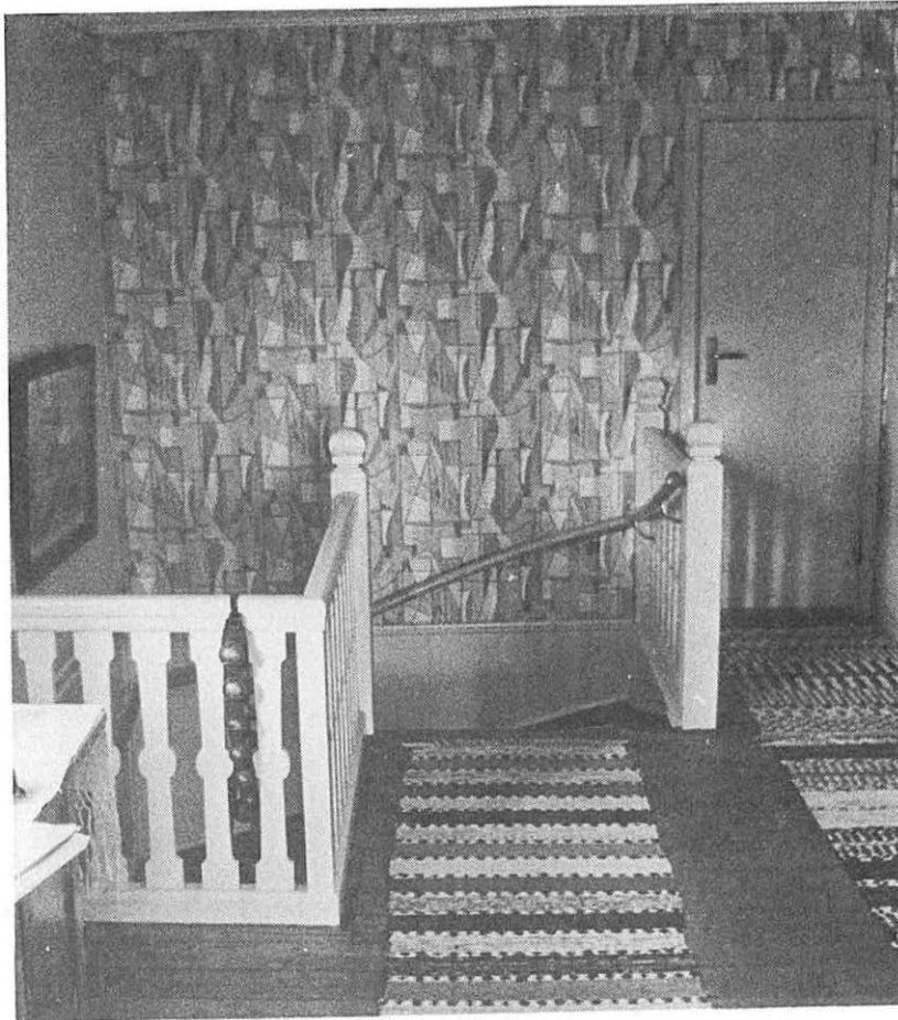
Hall. Skurgolv, tapet, vit spänd papp. WC och vindstrapp har linoleum på golvet och masonit på väggarna.
