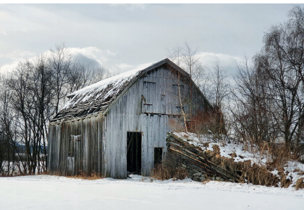
Løa til Peder Sagmoen, Tunnenga, Tynset 2021.
