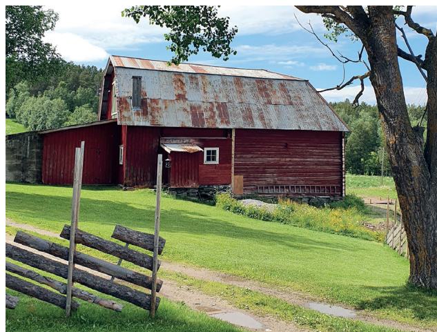
Brekken østre, Tynset.
