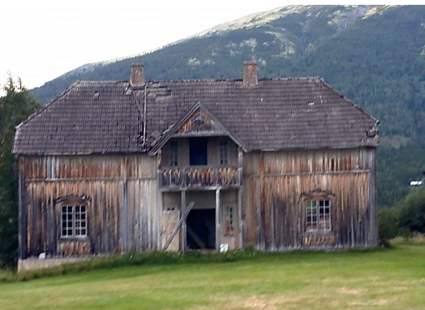
Storstrøm i Alvdal, ombygd østerdalsstue, 2017.
