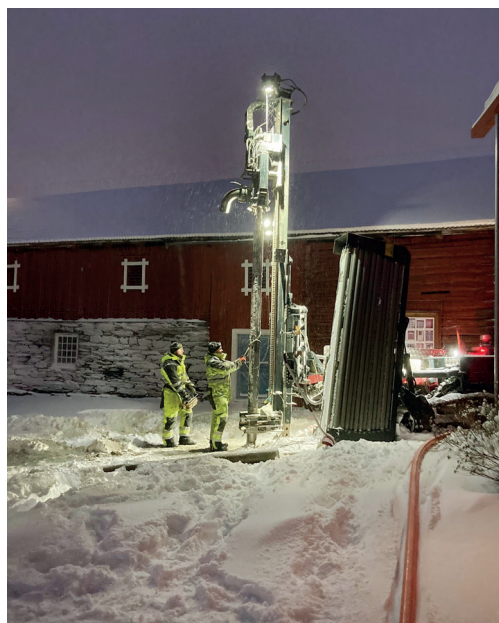
Det bores etter jordvarme på Ramsmoen.
