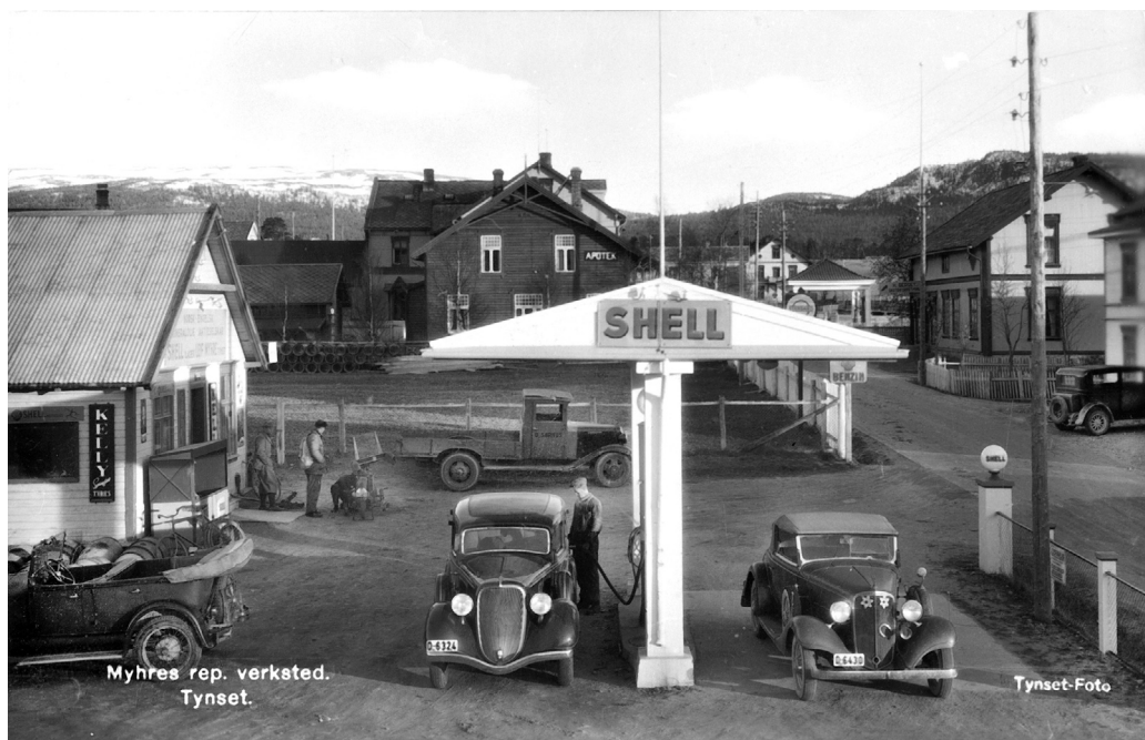
Shell bensinstasjon og Myhres verksted i Brugata på Tynset. Foto: Tynset Foto (postkort) / MINØ.049231
