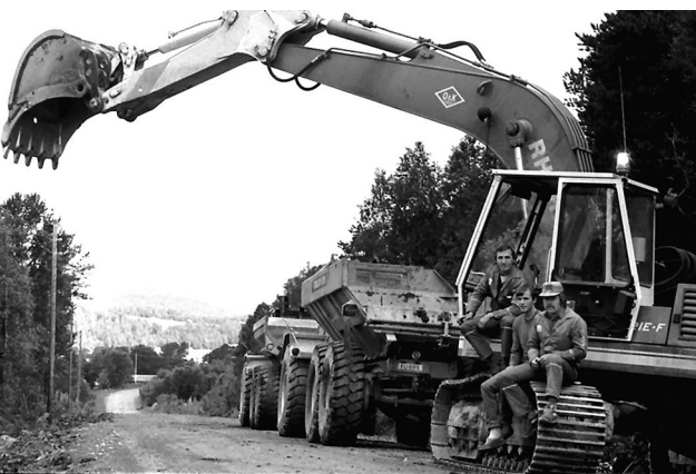
Veiarbeid i Dalsbygda i 1984. Foto: Per Magne Grue / Østlendingen / MINØ.105396
