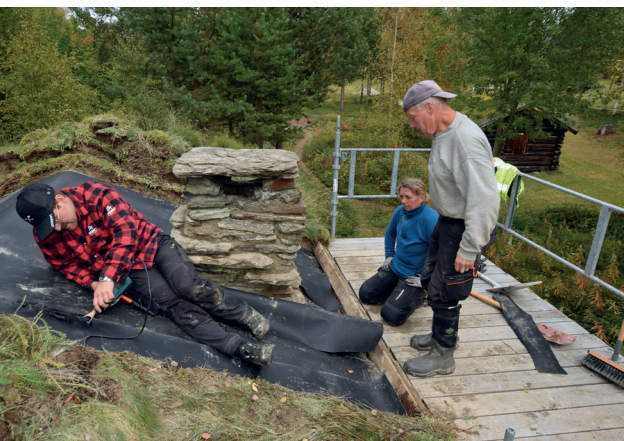
Taket og pipa på setra i Museumsparken får nødvendig reparasjon.
