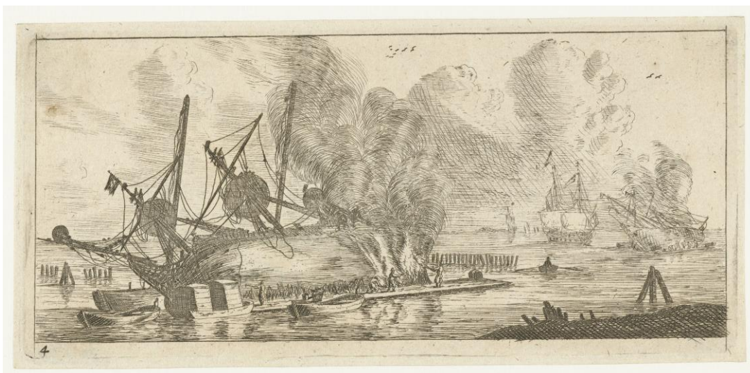
Fig 15. Etsning av Reinier Nooms, Vattentätning av ett fartygs skrov. 1600-talets första hälft.
