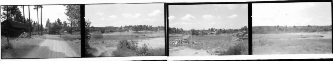
Östra Deje förs 1:12 Översikt Pimmansåsen Översikt Herrgård och kraftstation Översikt Kajavägen
