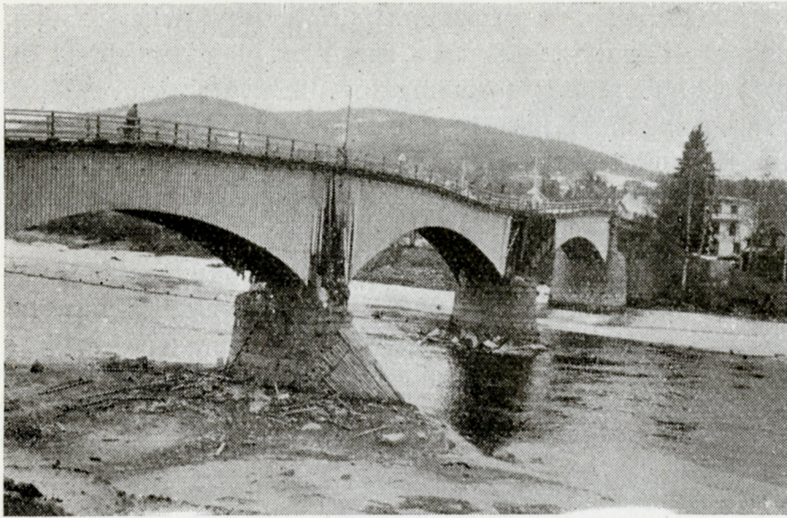
Fig. 1. Kongsvinger gamle bru etter sprengningen 16. april 1940. Foto tatt 17. april. Bemerkt (hvis reproduksjonen gjør det mulig) de tyske tropper på pillaren.
