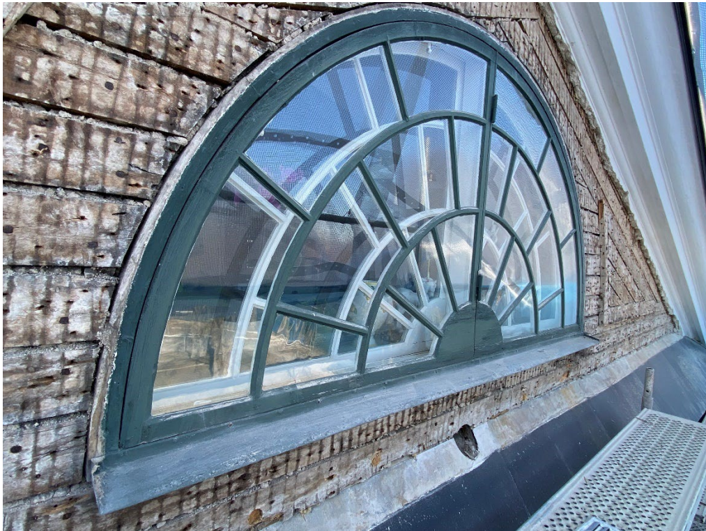
Figur 7. Under pågående arbeten. Lunettfönstret i frontonen. Här syns att den profilerade takfoten kunde renoveras utan att den till fullo behövde knackas ner. Foto: Ulrika Olsson, 2023-04-18.
