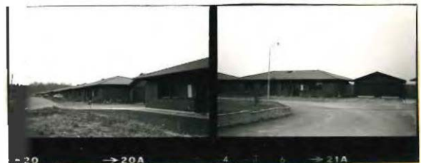
Hälltorp 1:123-1:130 Astervägen, västra slingan, västra sidan från N
