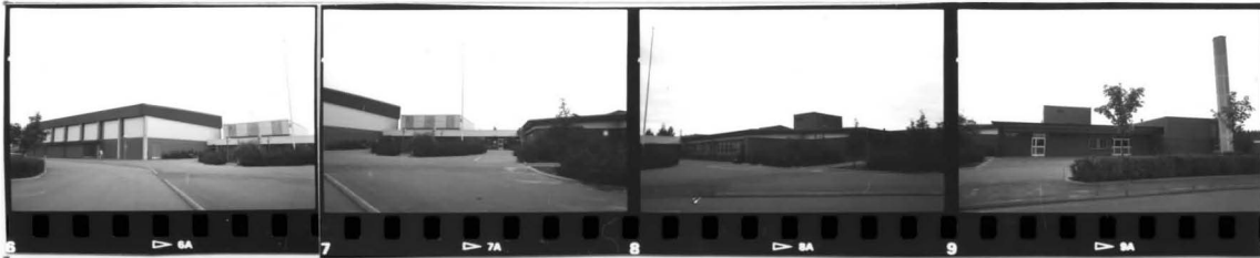
Hammar 1:402 Hammarlundens skola. Ö:a delen mot N. Idrottshall. Hammar 1:402 Hammarlundens skola. Centrala delen. N. Hammar 1:402 Hammarlundens skola. Biblioteks- delen. NO. Hammar 1:402 Hammarlundens skola. Del av v:a delen. N. Kök.
