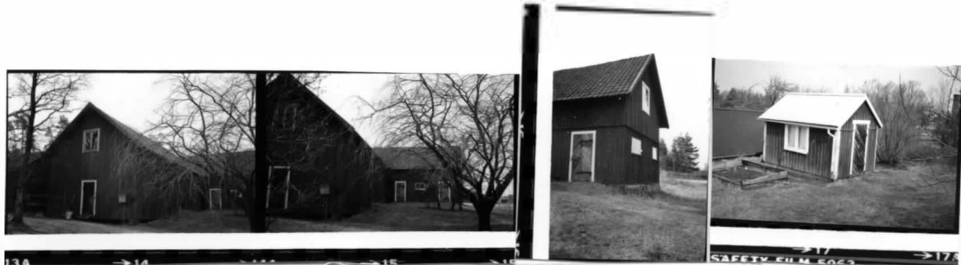
→ 14 → 15 → 16 → 17 II NV II NV II NV III S norra längan västra längan västra längan
