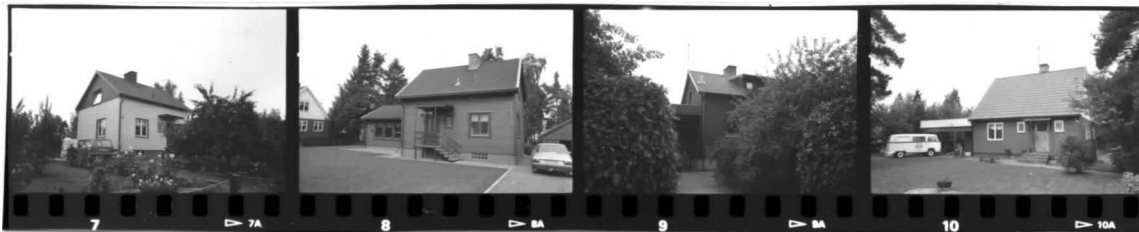
Haga 1:34 Skoghemsvägen 12 NO Haga 1:29 Skoghemsvägen 9 SO Haga 1:53 Skoghemsvägen 10 NO Haga 1:30 Skoghemsvägen 7 NO
