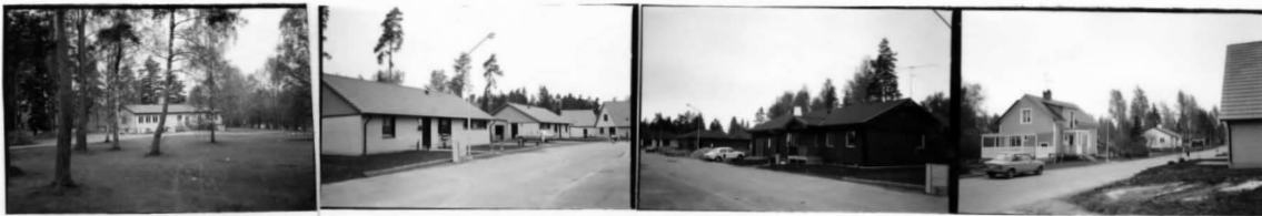
→ 8 → 8A → 18 → 18A → 19 → 19A → 20 → 20A Lövnäs 1: 65 NO Lövnäs 1: 197, 1: 196 Grindstugev. 41 och 43 NO Lövnäs 1: 79, 1: 219 Grindstugev. 39 och 37 N Lövnäs 1: 140, 1: 141 Grindstugev. 9 och 13 SU
