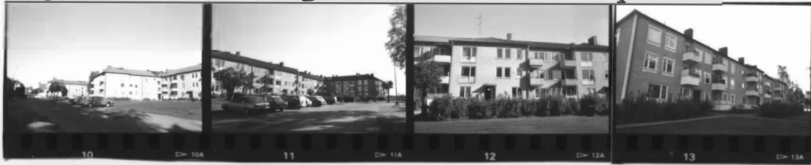
Solgatan mot SO.
