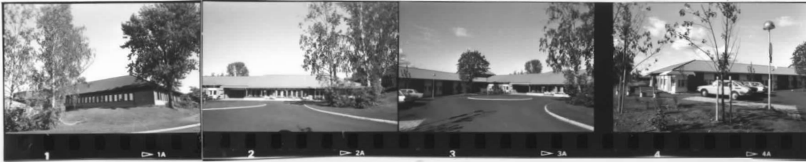
Lunden 1:90 Lunden 1:90 Lunden 1:90 Lunden 1:90 Vårdcentralen Skoghall's sjukhem Skoghall's sjukhem Skoghall's sjukhem Se bild 143:24 ö-delen. s mittdelen. s-delen. so so
